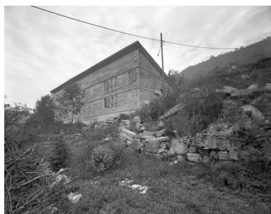
Façade postérieure. Phot. Jérôme Mongreville IVR43_19913900721V
