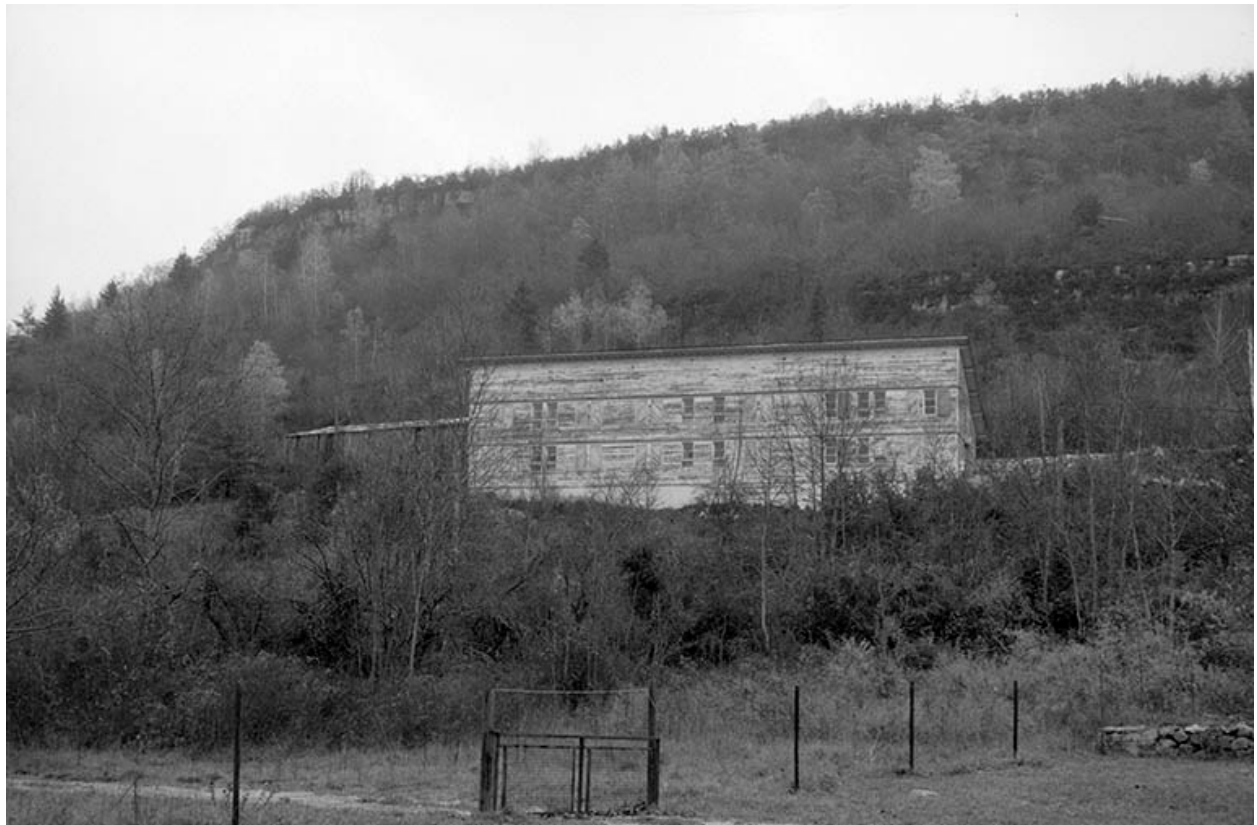
Vue d'ensemble depuis l'ouest (façade postérieure).
