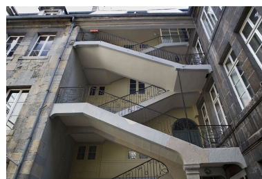
Détail de la partie supérieure de l'escalier à cage ouverte. Phot. Yves Sancey IVR43_20082500245NUC2A
