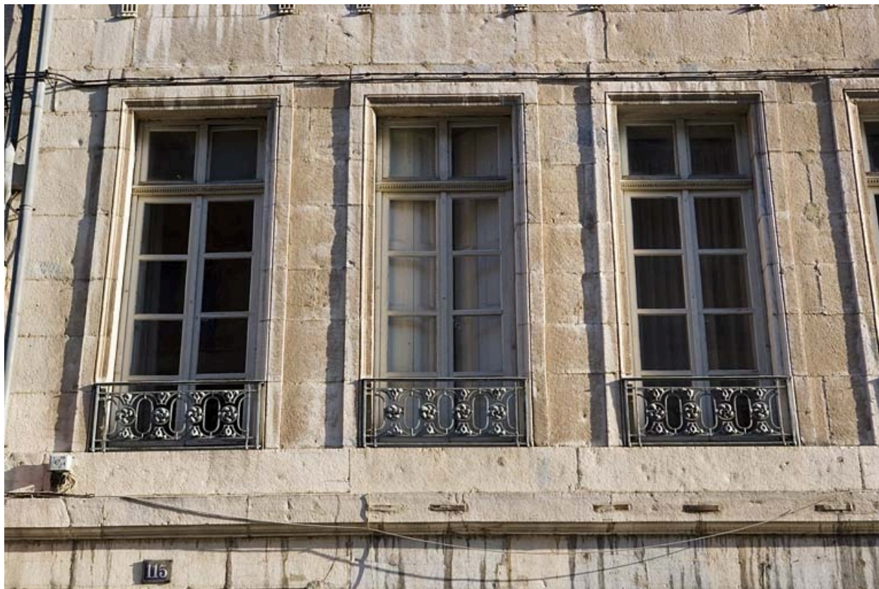
Logis principal sur rue : détail de fenêtres du premier étage.
