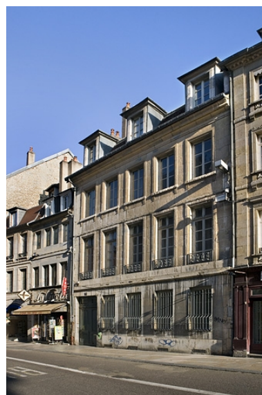
Vue d'ensemble du logis principal sur rue.
