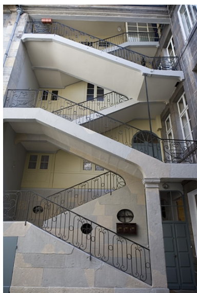
Vue d'ensemble de l'escalier à cage ouverte. Phot. Yves Sancey IVR43_20082500241NUC2A
