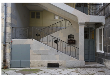
Détail des premières volées de l'escalier à cage ouverte. Phot. Yves Sancey IVR43_20082500244NUC2A
