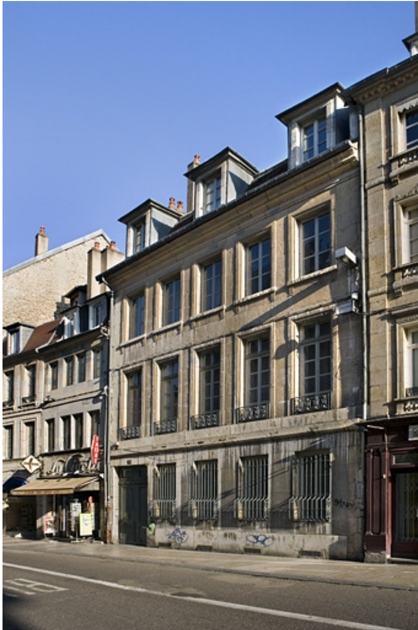
Vue d'ensemble du logis principal sur rue.
