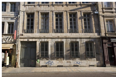
Logis principal sur rue : détail du rez-de-chaussée et du premier étage. Phot. Yves Sancey IVR43_20082500239NUC2A
