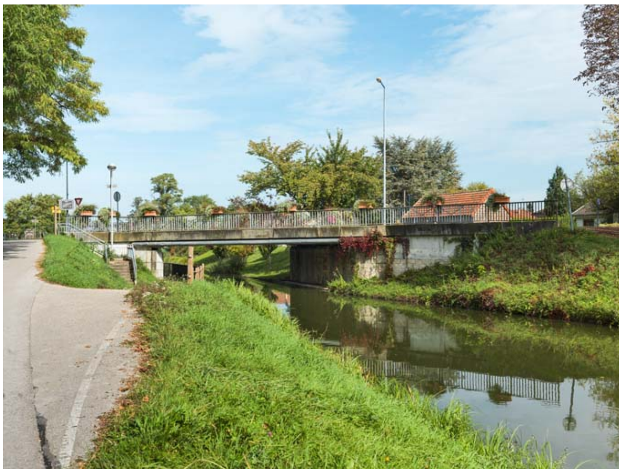
Vue d'ensemble du pont.
