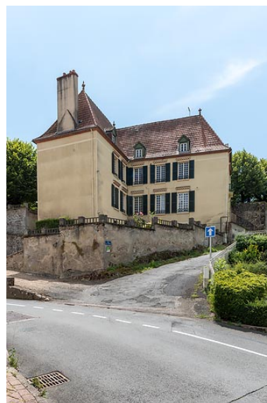
Vue depuis la place d'Aligre. Phot. Pierre-Marie Barbe-Richaud IVR26_20217100246NUC4A
