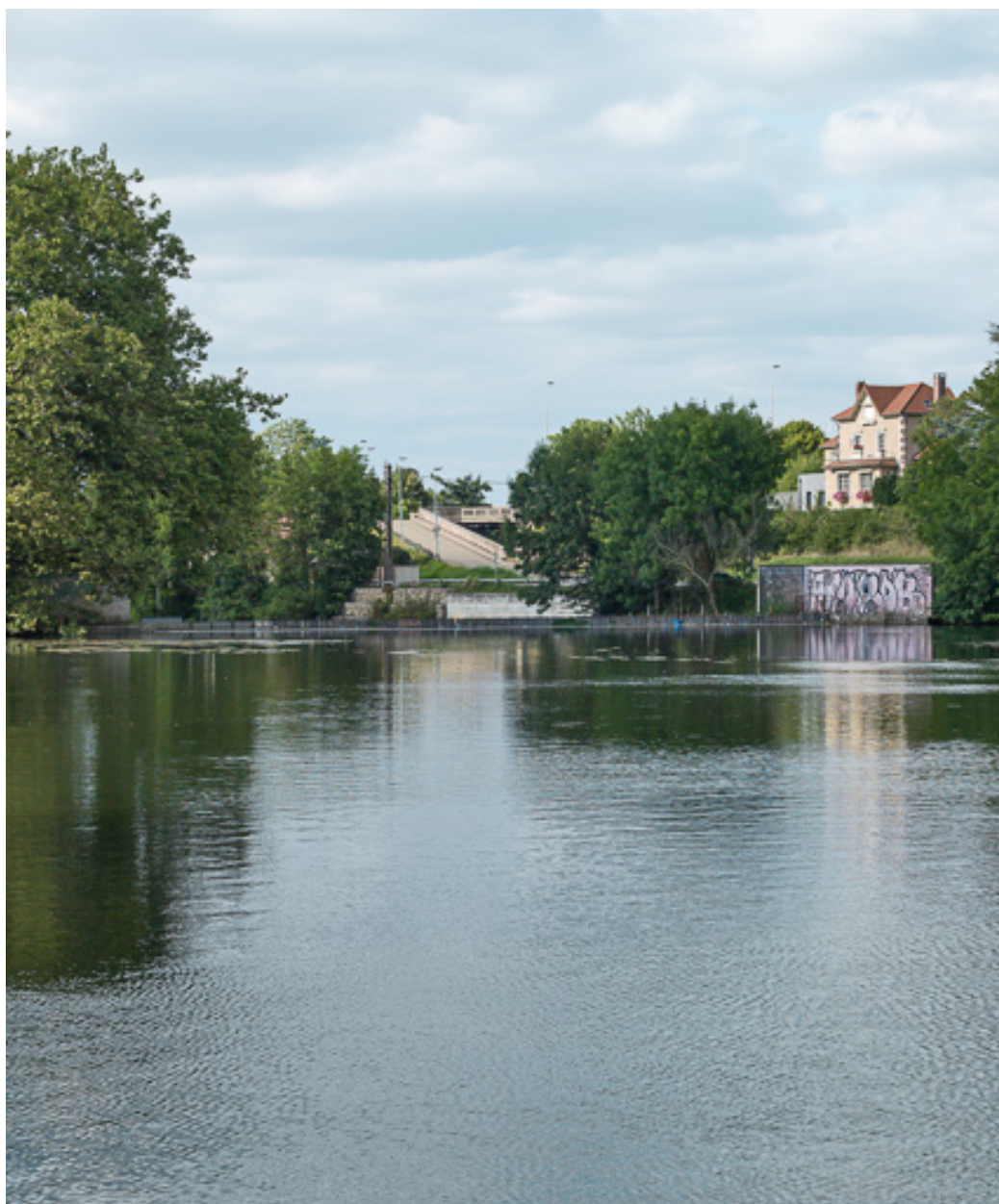
Vue du barrage.
