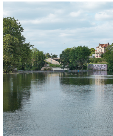
Vue du barrage. Phot. Pierre-Marie Barbe-Richaud IVR26_20178900194NUC2A
