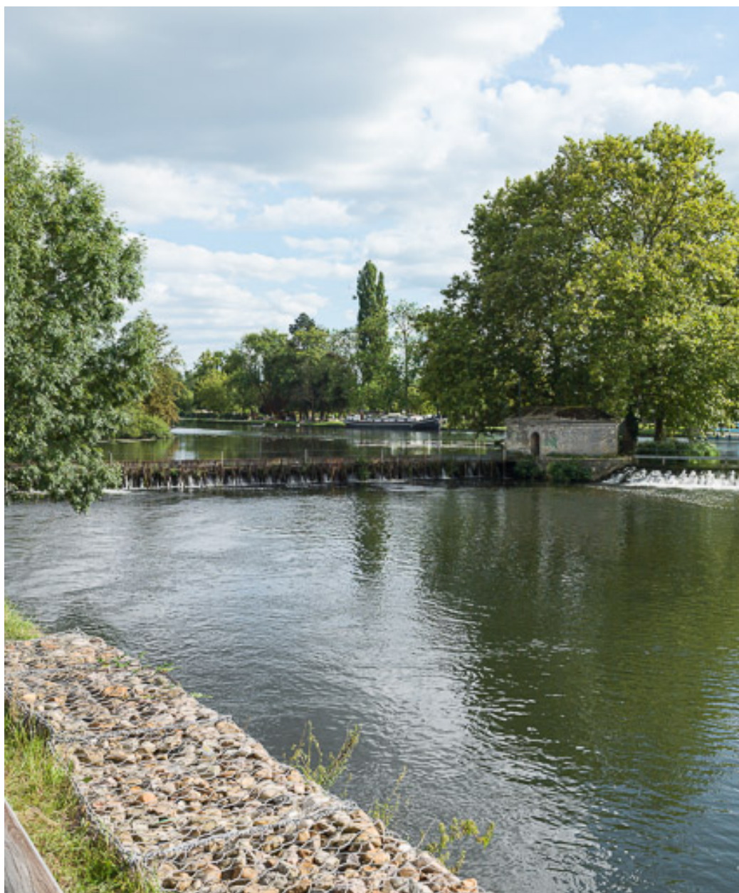
Vue du barrage.
