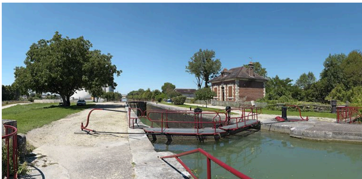
Vue d'ensemble du site d'écluse.
