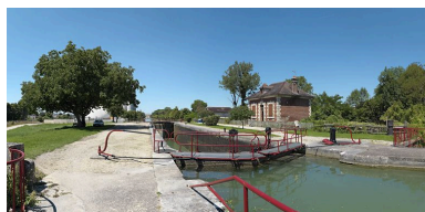
Vue d'ensemble du site d'écluse.
