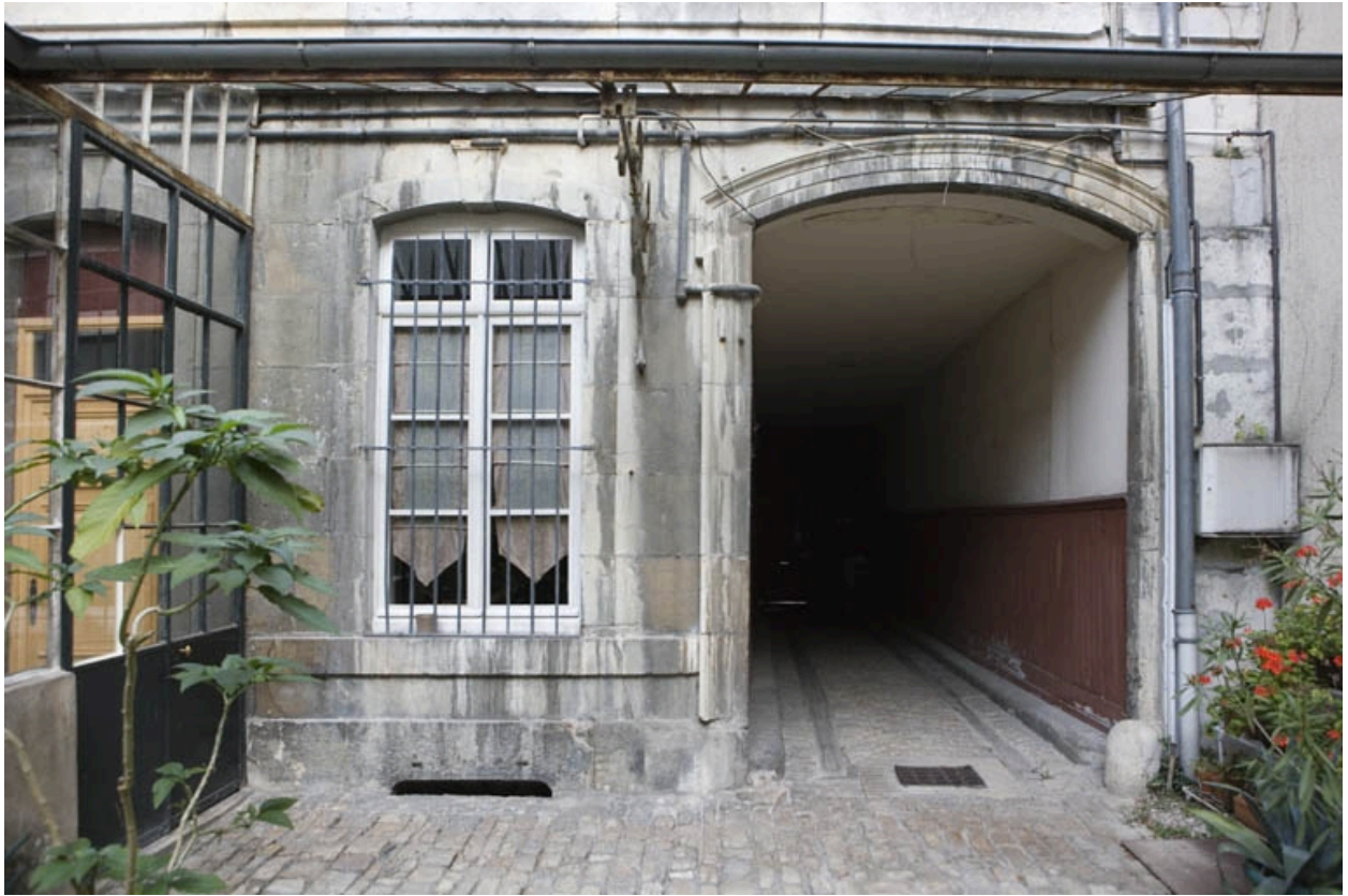
Détail du passage cocher, côté cour.
