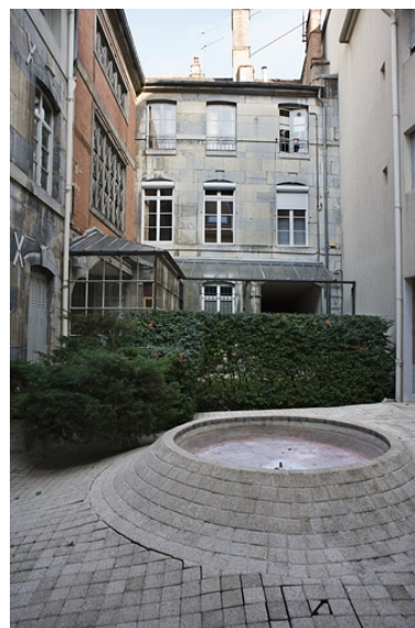
Vue d'ensemble des façades sur cour du logis principal, de face.
