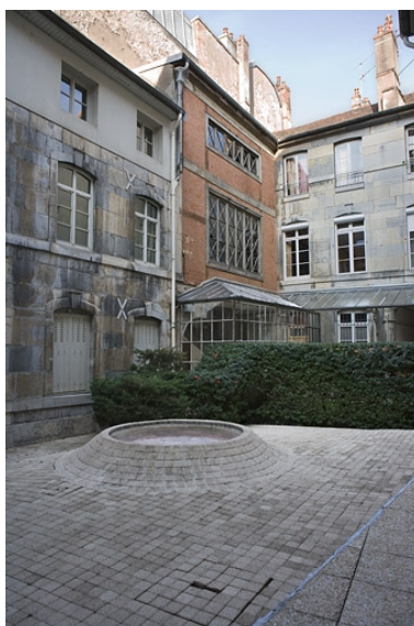
Vue d'ensemble des façades sur cour du logis principal, de trois quarts droit. Phot. Yves Sancey IVR43_20092501433NUC2A
