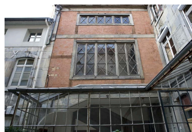
Détail de l'aile contenant l'escalier principal. Phot. Yves Sancey IVR43_20092501434NUC2A
