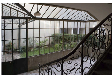
Vue intérieure de la verrière protégeant le rez-de- chaussée de la cage d'escalier. Phot. Yves Sancey IVR43_20092501437NUC2A
