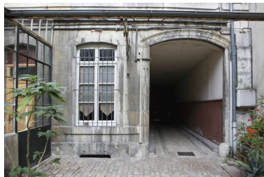
Détail du passage cocher, côté cour. Phot. Yves Sancey IVR43_20092501431NUC2A
