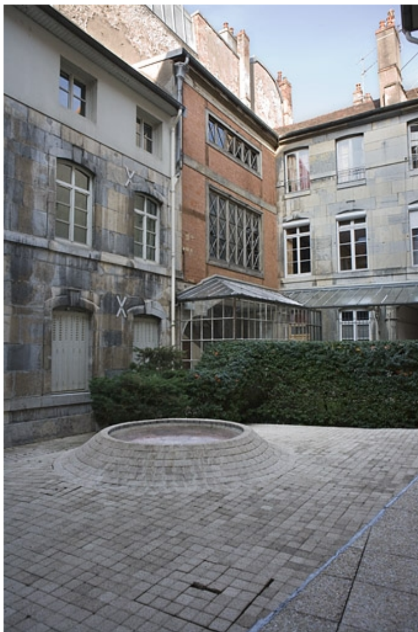
Vue d'ensemble des façades sur cour du logis principal, de trois quarts droit.
