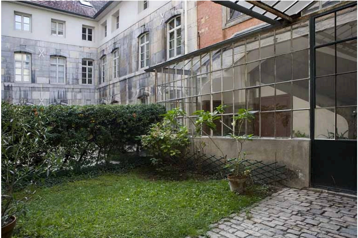
Vue d'ensemble des communs depuis l'entrée de la cour.
