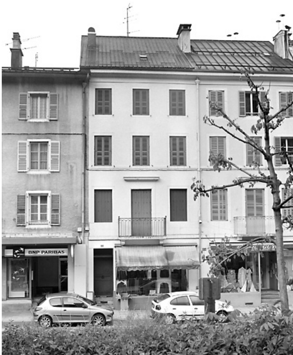
Elévation antérieure du n° 126.
