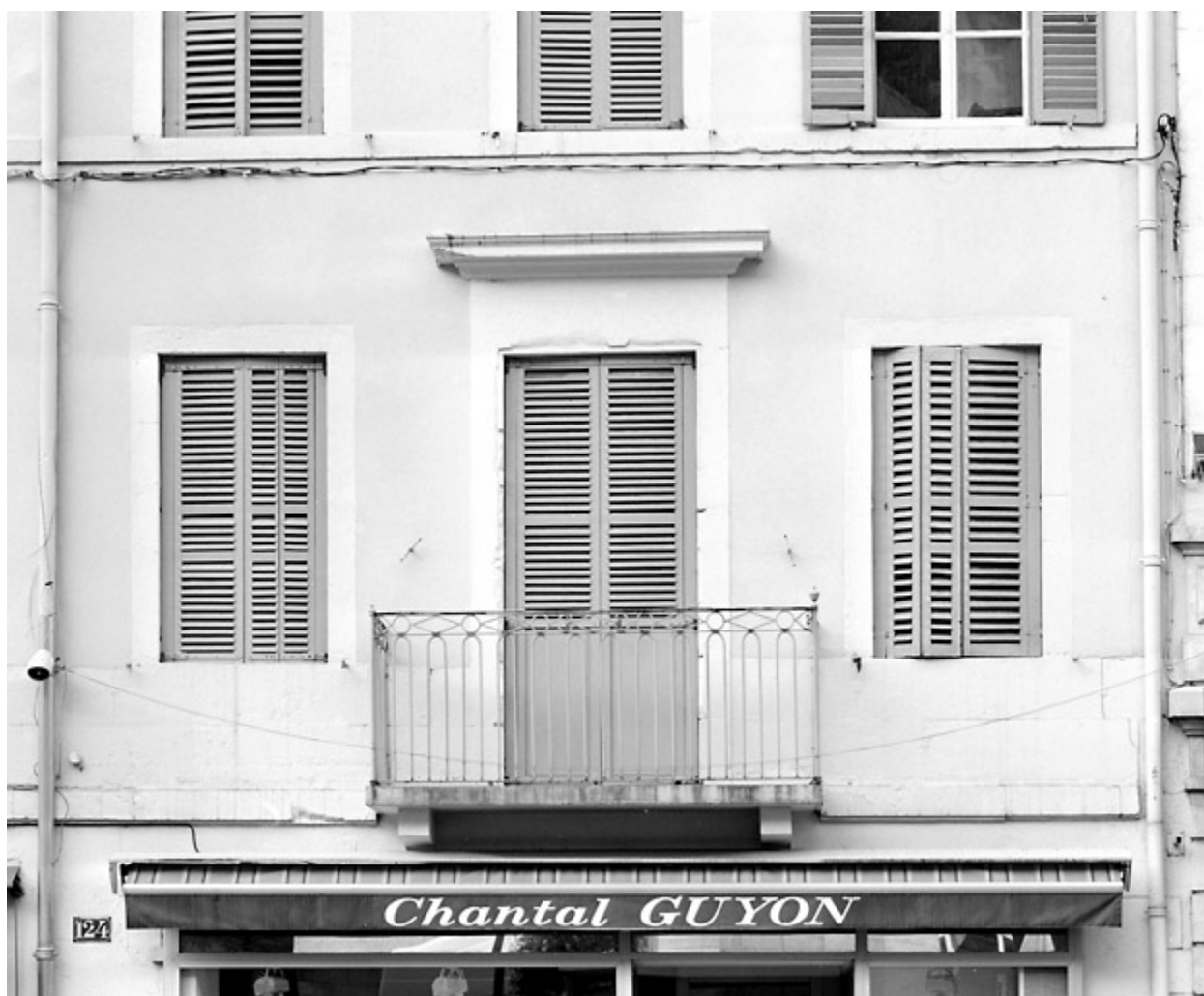
Premier étage du n° 124.
