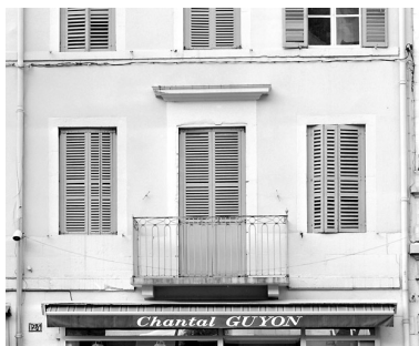
Premier étage du n° 124. Phot. Yves Sancey IVR43_20033900790X
