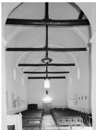
La nef, vue d'ensemble depuis la croisée du transept. Phot. Michel Rosso IVR26_19815800255V
