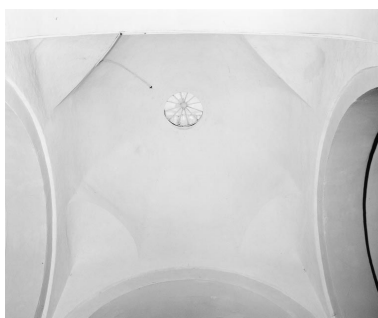
Détail de la voûte de la croisée du transept. Phot. Jean-Luc Duthu IVR26_19815800258X
