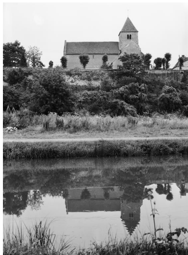
Vue d'ensemble depuis le canal. Phot. Michel Rosso IVR26_19815800246V
