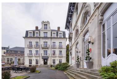
Situation de l'hôtel, à proximité immédiate de l'hôtel des Thermes. Phot. Jérôme Mongreville IVR43_20207000637NUC4A
