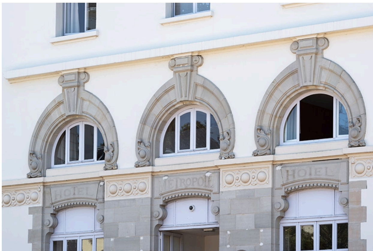
Façade nord, vue de trois quarts, détail.
