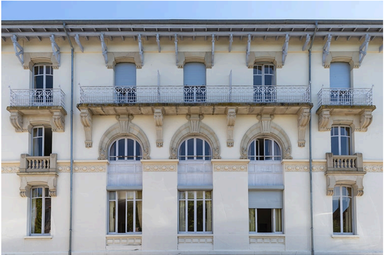
Façade ouest, vue de face, détail.
