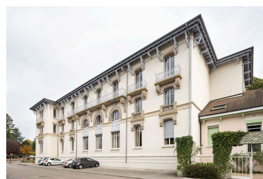
Façade ouest, vue de trois quarts depuis le sud-ouest. Phot. Jérôme Mongreville IVR43_20207000636NUC4A
