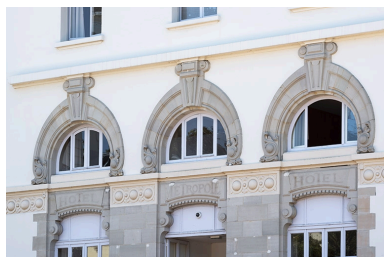
Façade nord, vue de trois quarts, détail. Phot. Jérôme Mongreville IVR43_20207000629NUC4A
