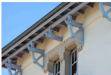
Aisseliers de la saillie de rive. Phot. Jérôme Mongreville IVR43_20207000621NUC4A
