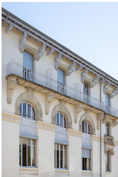
Façade ouest, vue de trois quarts, détail. Phot. Jérôme Mongreville IVR43_20207000625NUC4A
