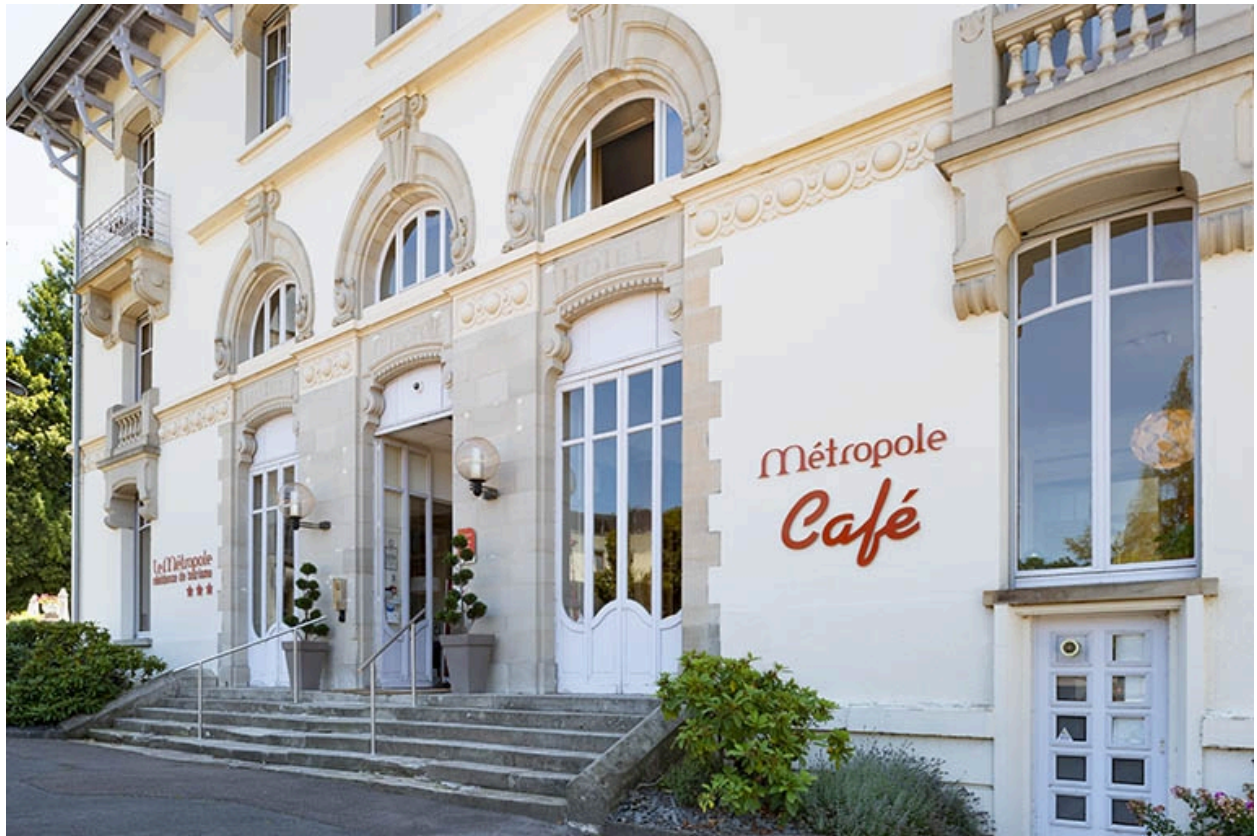
Façade nord, vue de trois quarts, détail.
