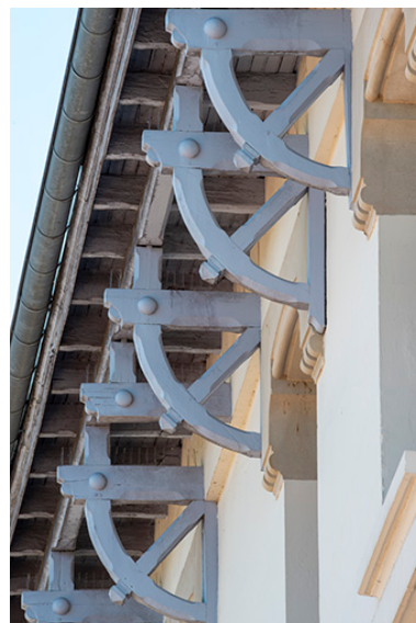
Aisseliers de la saillie de rive. Phot. Jérôme Mongreville IVR43_20207000628NUC4A
