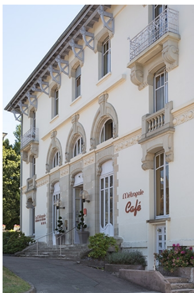
Façade nord, vue de trois quarts, détail. Phot. Jérôme Mongreville IVR43_20207000627NUC4A
