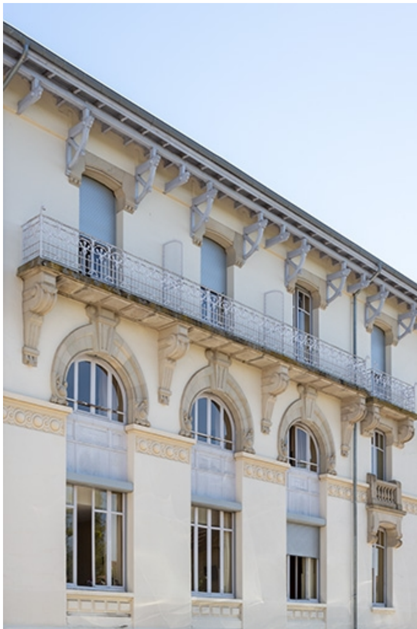
Façade ouest, vue de trois quarts, détail.
