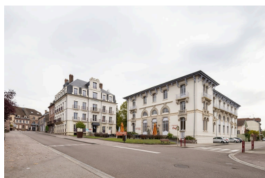
Situation de l'hôtel, au croisement de la rue des Thermes (à gauche) et du boulevard Richet (à droite). Phot. Jérôme Mongreville IVR43_20207000634NUC4A
