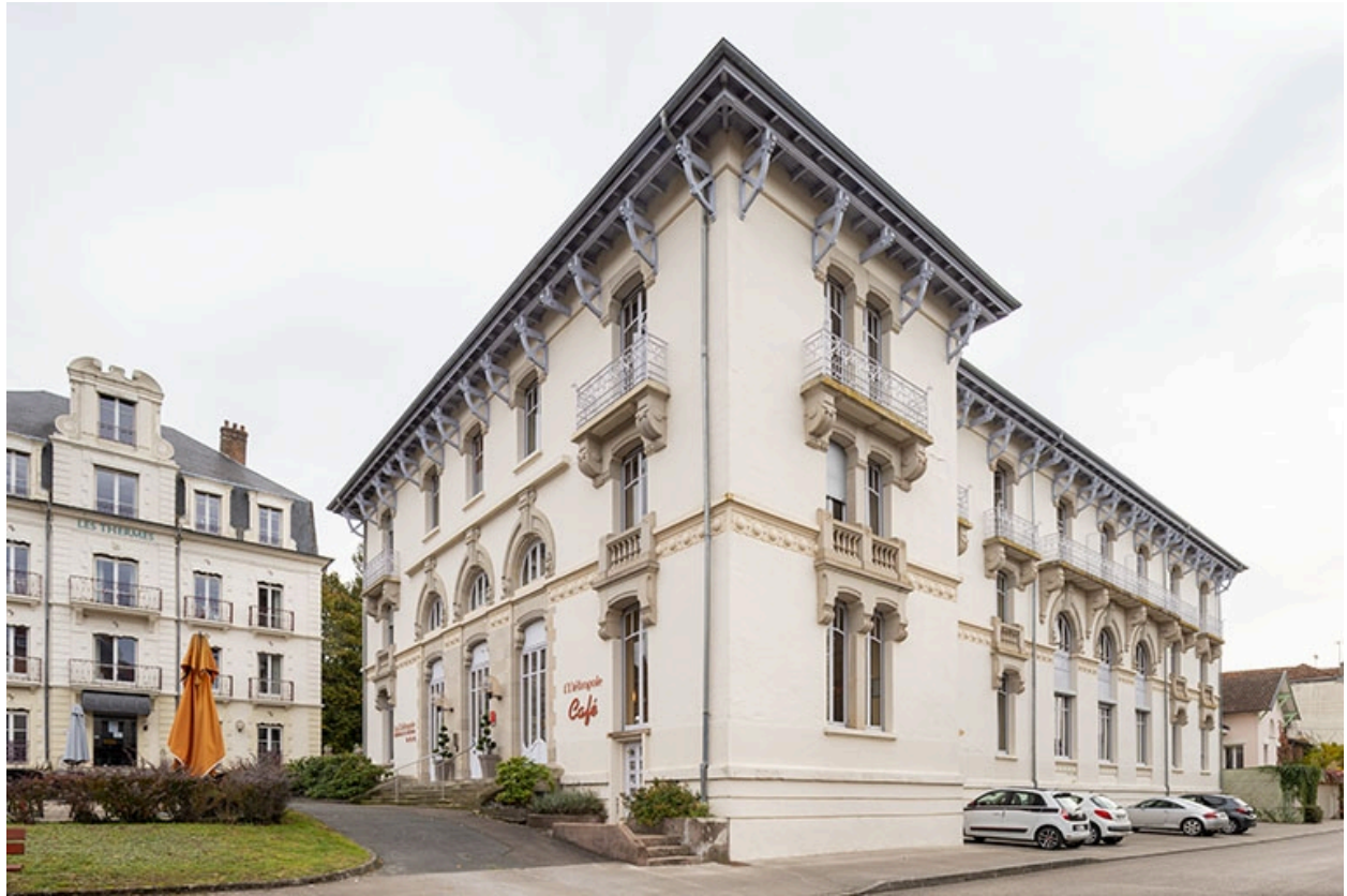
Façade ouest, vue de trois quarts depuis le nord-ouest.
