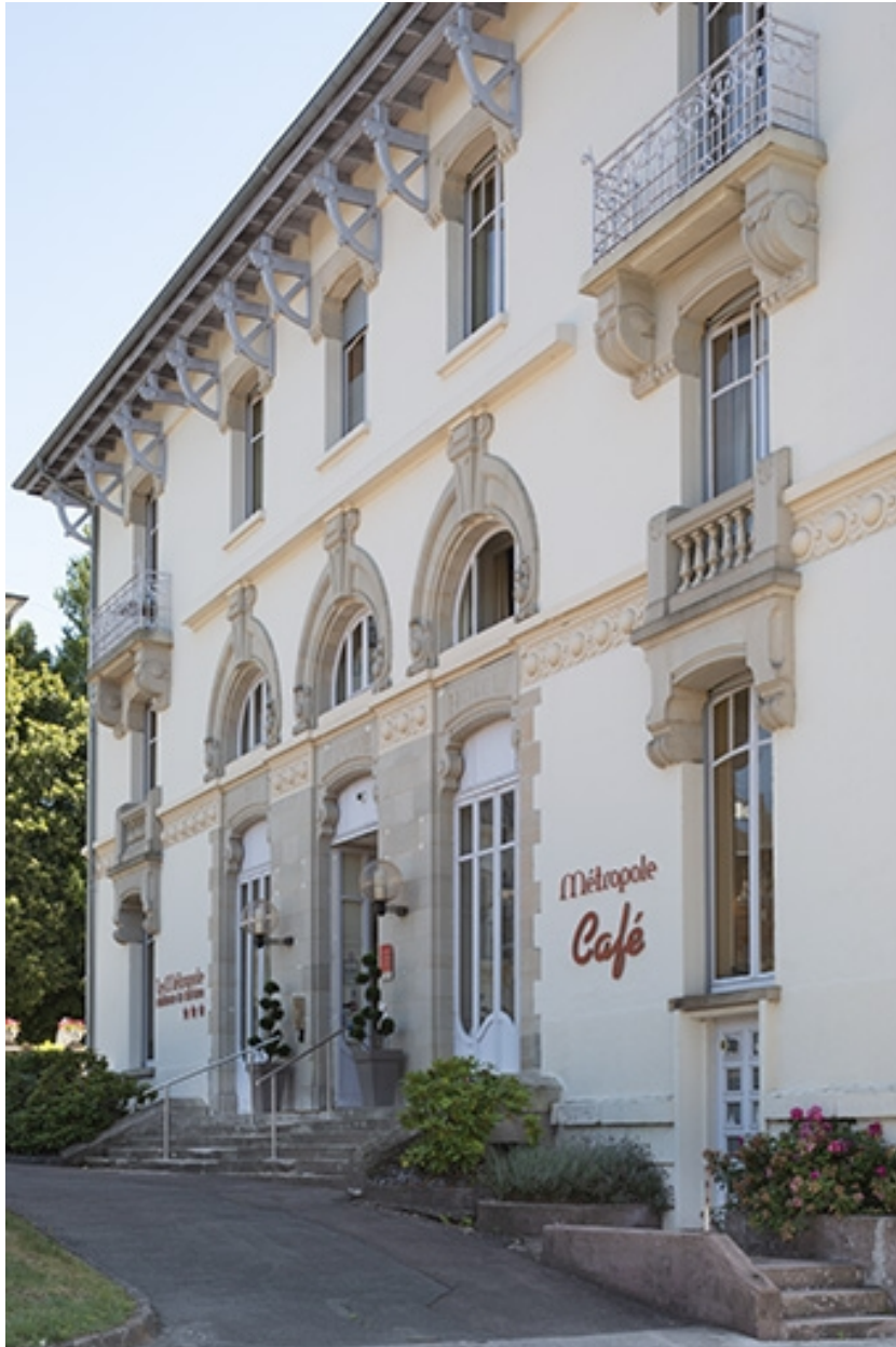
Façade nord, vue de trois quarts, détail.
