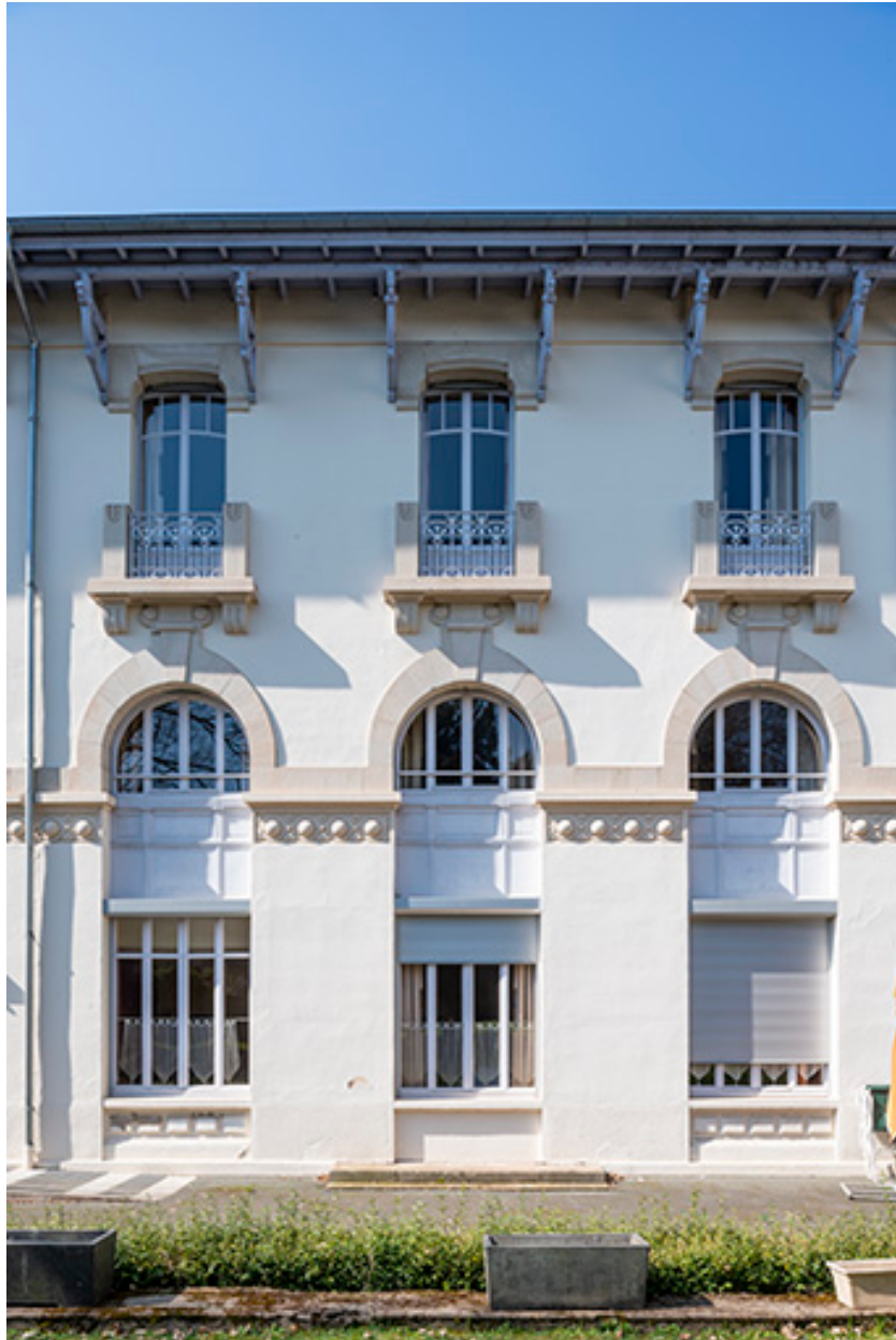
Façade est, vue de face, détail.
