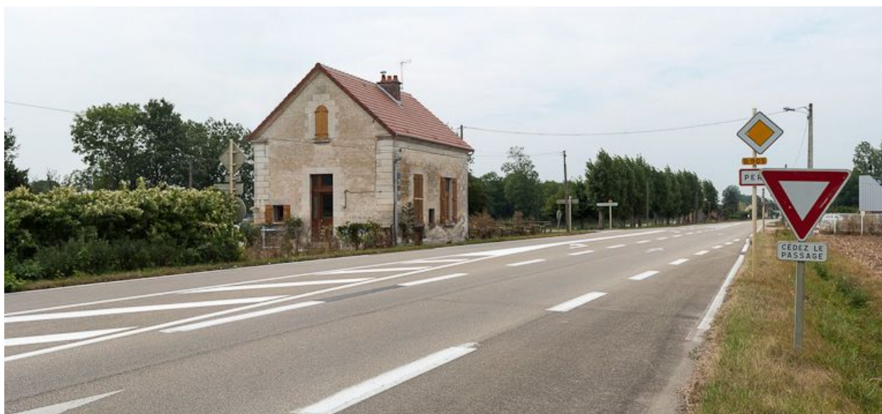
La maison éclusière depuis la route.
