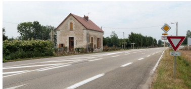
La maison éclusière depuis la route. Phot. Pierre-Marie Barbe-Richaud IVR26_20128900576NUC4AQ
