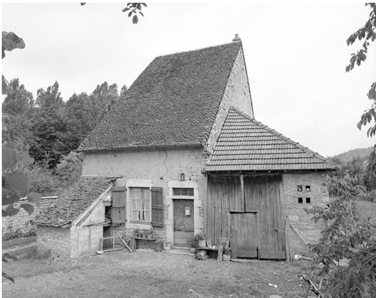
Maison : façade antérieure.
