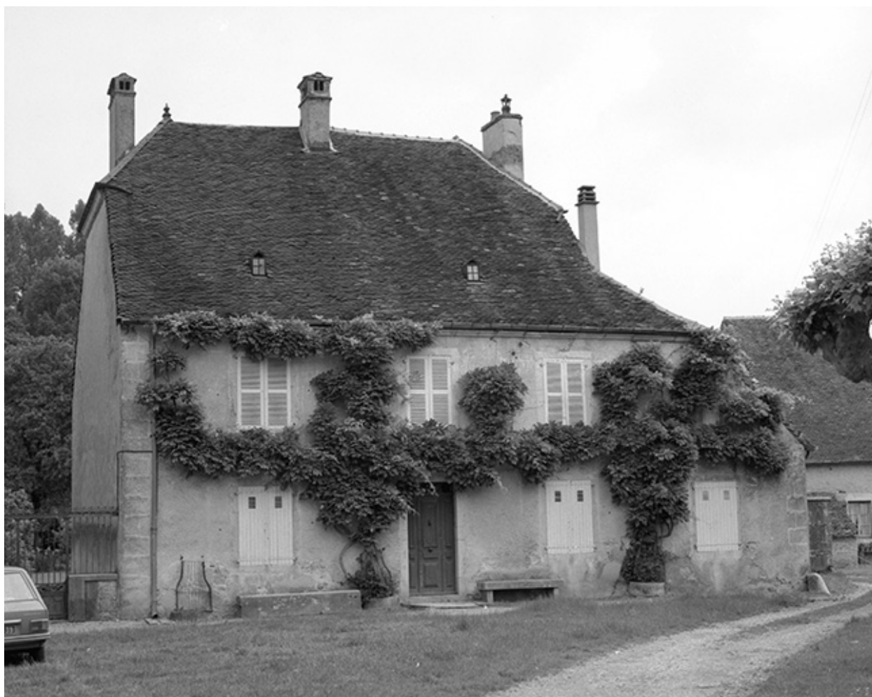
Maison : façade antérieure.
