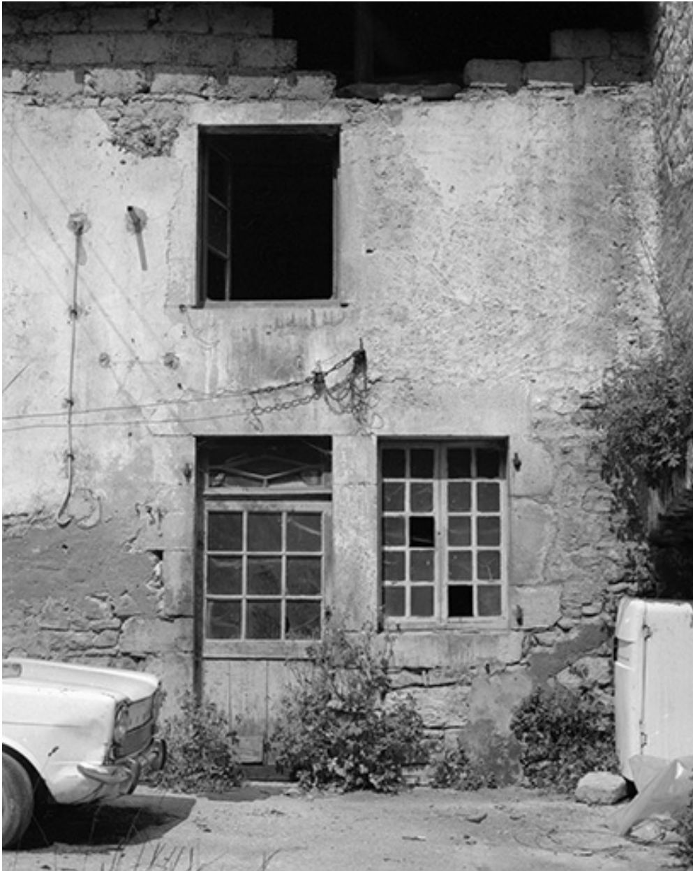
Maison : façade antérieure.
