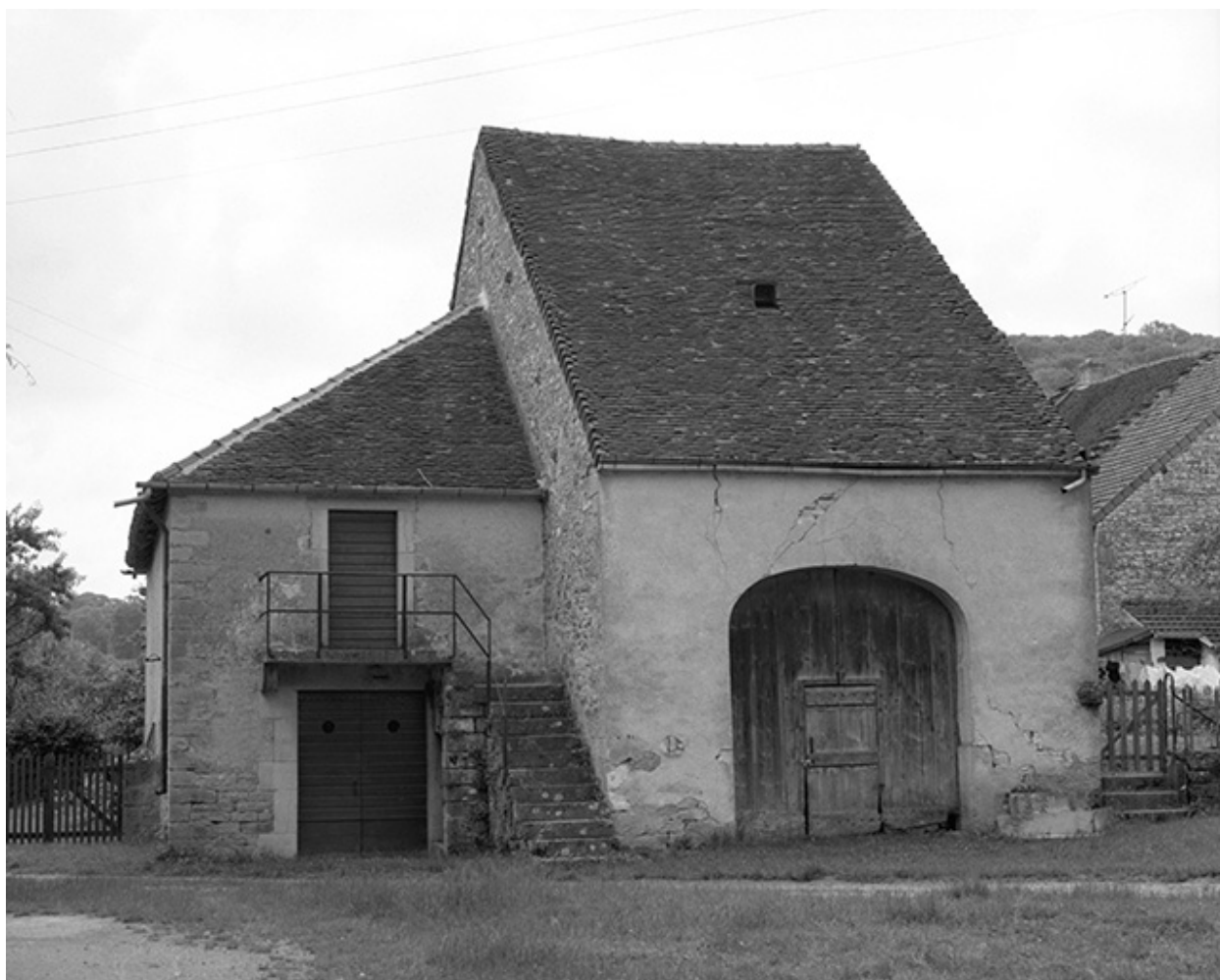
Ferme : façade postérieure.
