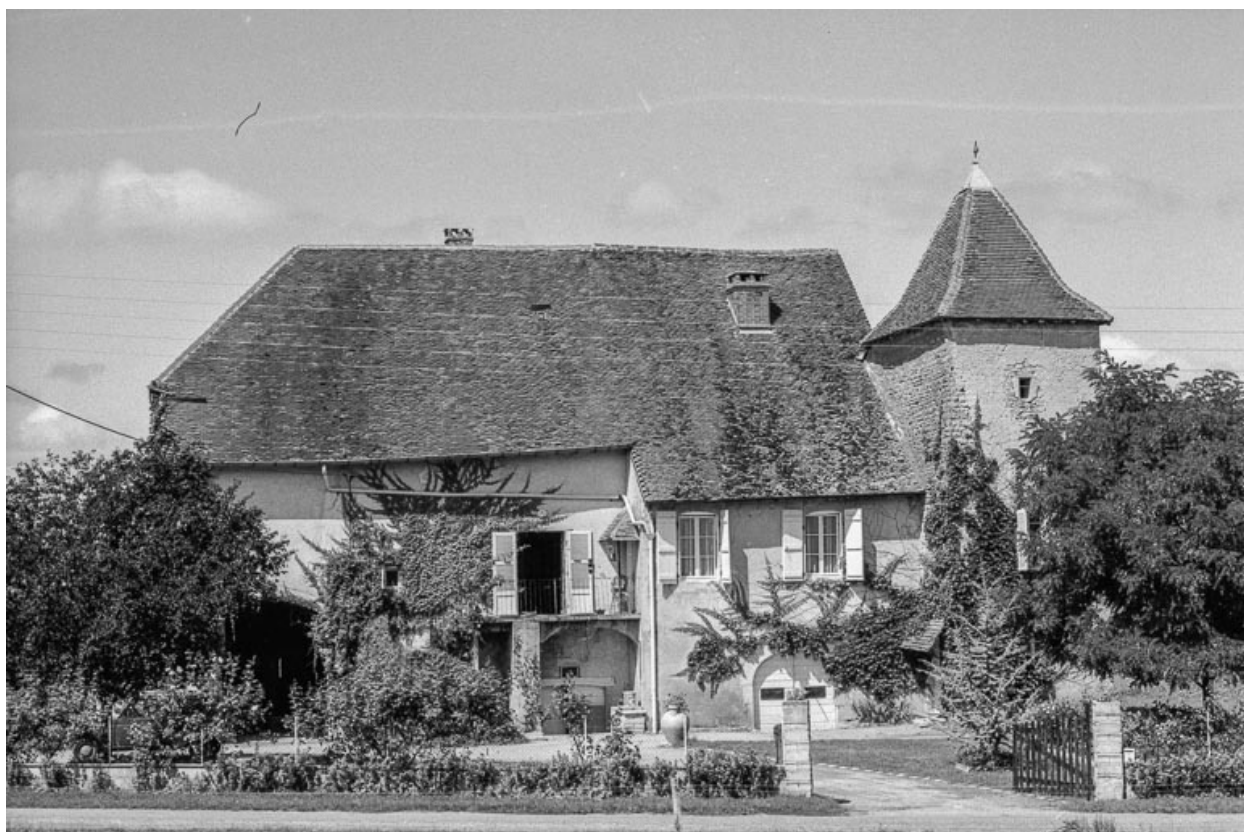
Maison : façade antérieure.
