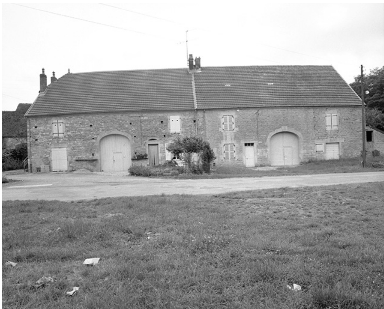
Fermes doubles : vue d'ensemble.
