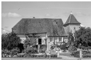
Maison : façade antérieure. Phot. Bernard Pontefract IVR43_19753900992Z
