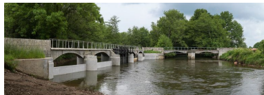
Barrage de prise d'eau sur l'Yonne. Phot. Pierre-Marie Barbe-Richaud IVR26_20135800420NUC4AQ
