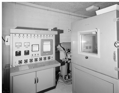
Vue d'ensemble. Phot. Jérôme Mongreville IVR43_20032500697V
