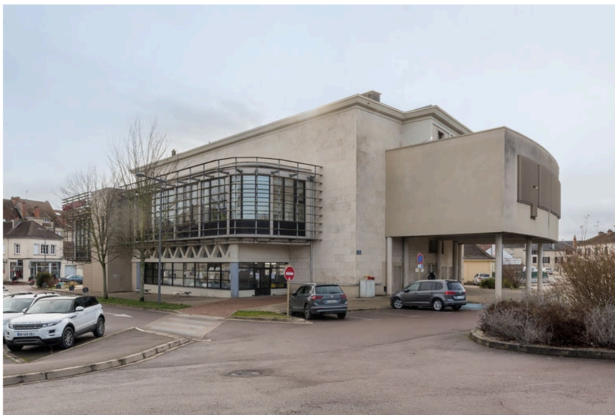
Façades postérieure et latérale gauche.
