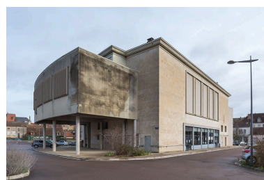
Façades postérieure et latérale droite. Phot. Pierre-Marie Barbe-Richaud IVR26_20212100400NUC4A
