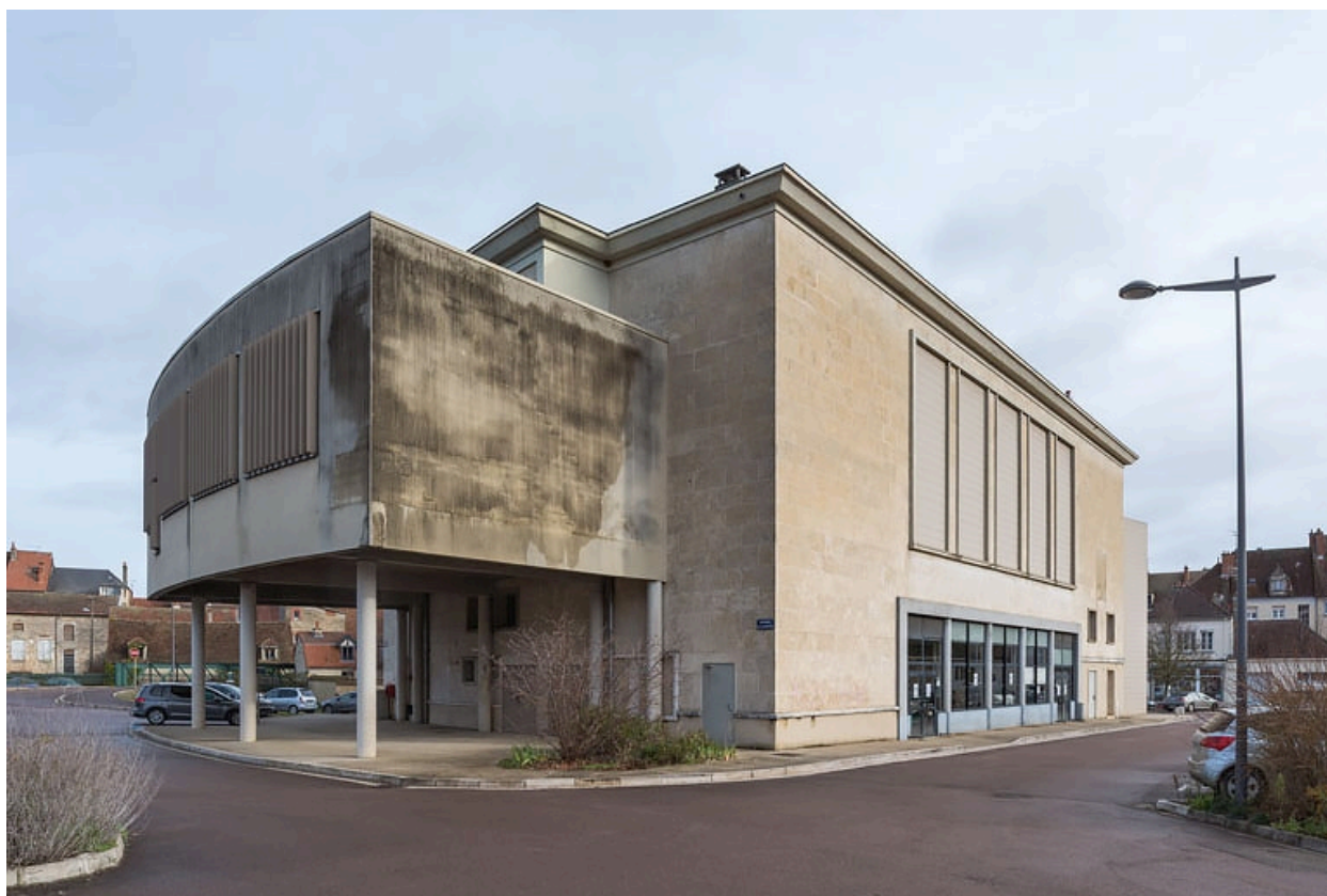
Façades postérieure et latérale droite.
