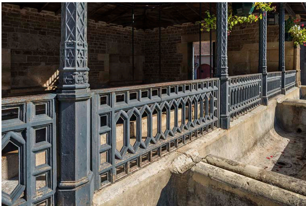
Le garde-corps en fonte.
