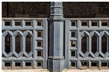
Détail du garde-corps et d'une colonne. Phot. Jérôme Mongreville IVR43_20177001317NUC4A
