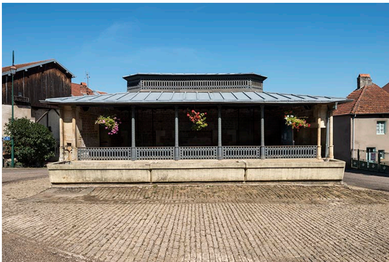
La façade antérieure de l'édifice.
