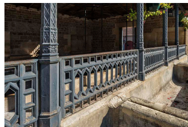
Le garde-corps en fonte. Phot. Jérôme Mongreville IVR43_20177001316NUC4A
