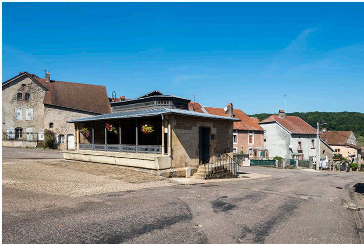
Vue depuis le haut de la rue du Vaux.
