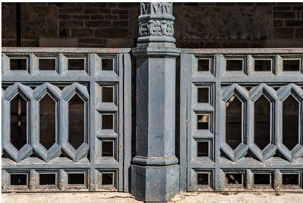
Détail du garde-corps et d'une colonne.
