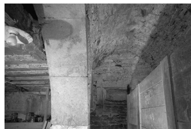
Intérieur : voûte de la cave. Phot. Gilbert Poinso IVR43_19762500867Z
