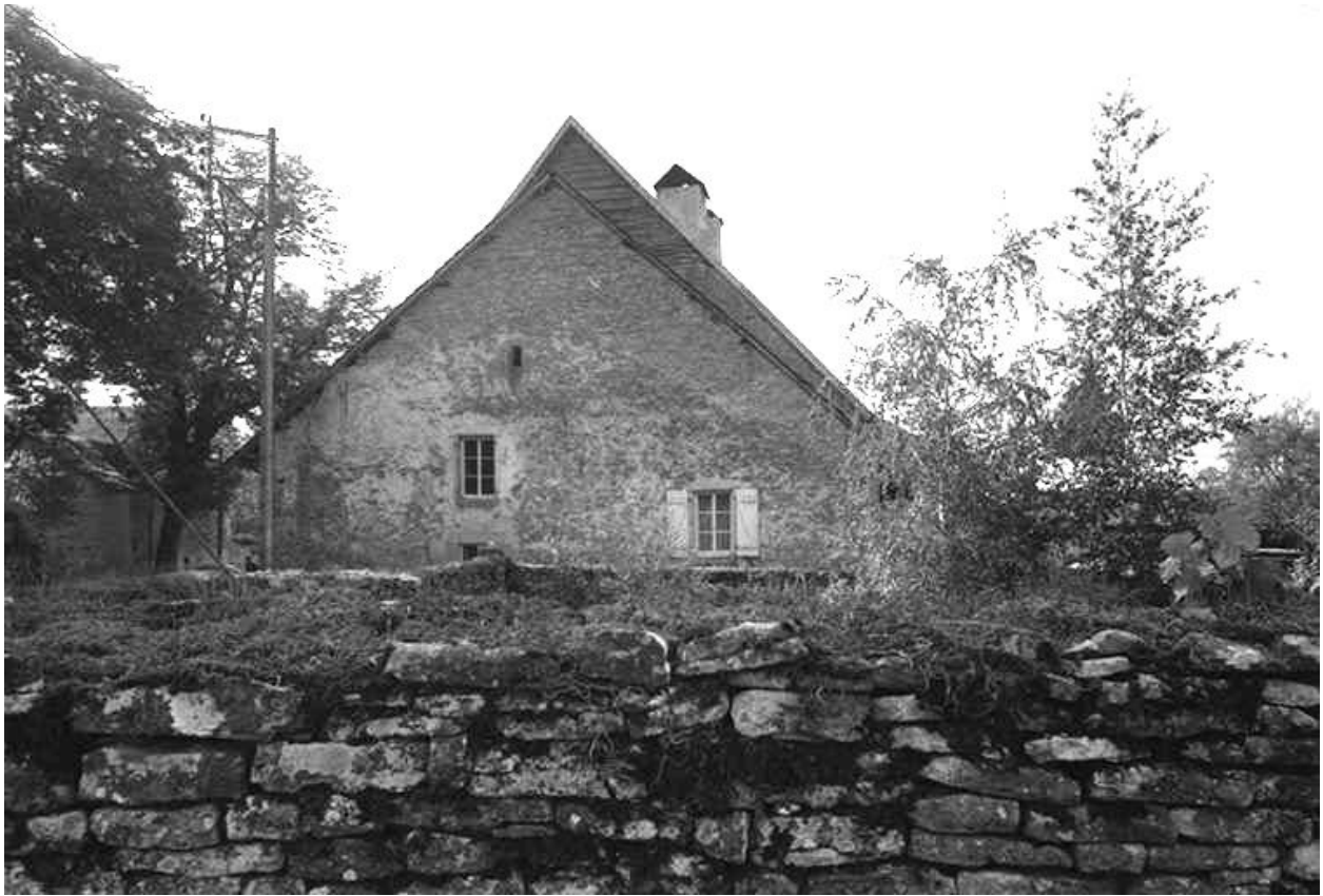
Façade latérale droite.
