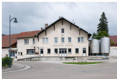
Façade antérieure. Phot. Jérôme Mongreville IVR43_20142501189NUC4A
