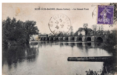
Scey-sur-Saône (Haute-Saône). - Le grand pont, carte postale. Phot. Jérôme Mongreville IVR43_20197000079NUC4A
