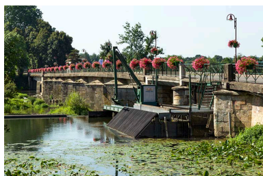
Le pont et la "portière" qui alimentait l'ancienne forge. Phot. Sonia Dourlot IVR43_20167001858NUC2A
