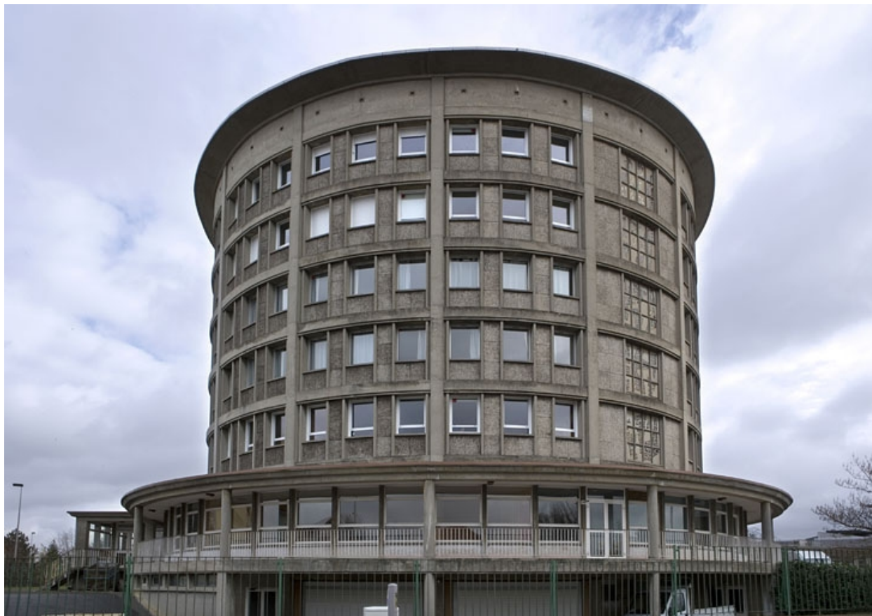
Bâtiment D. Vue de la tour d'internat.
