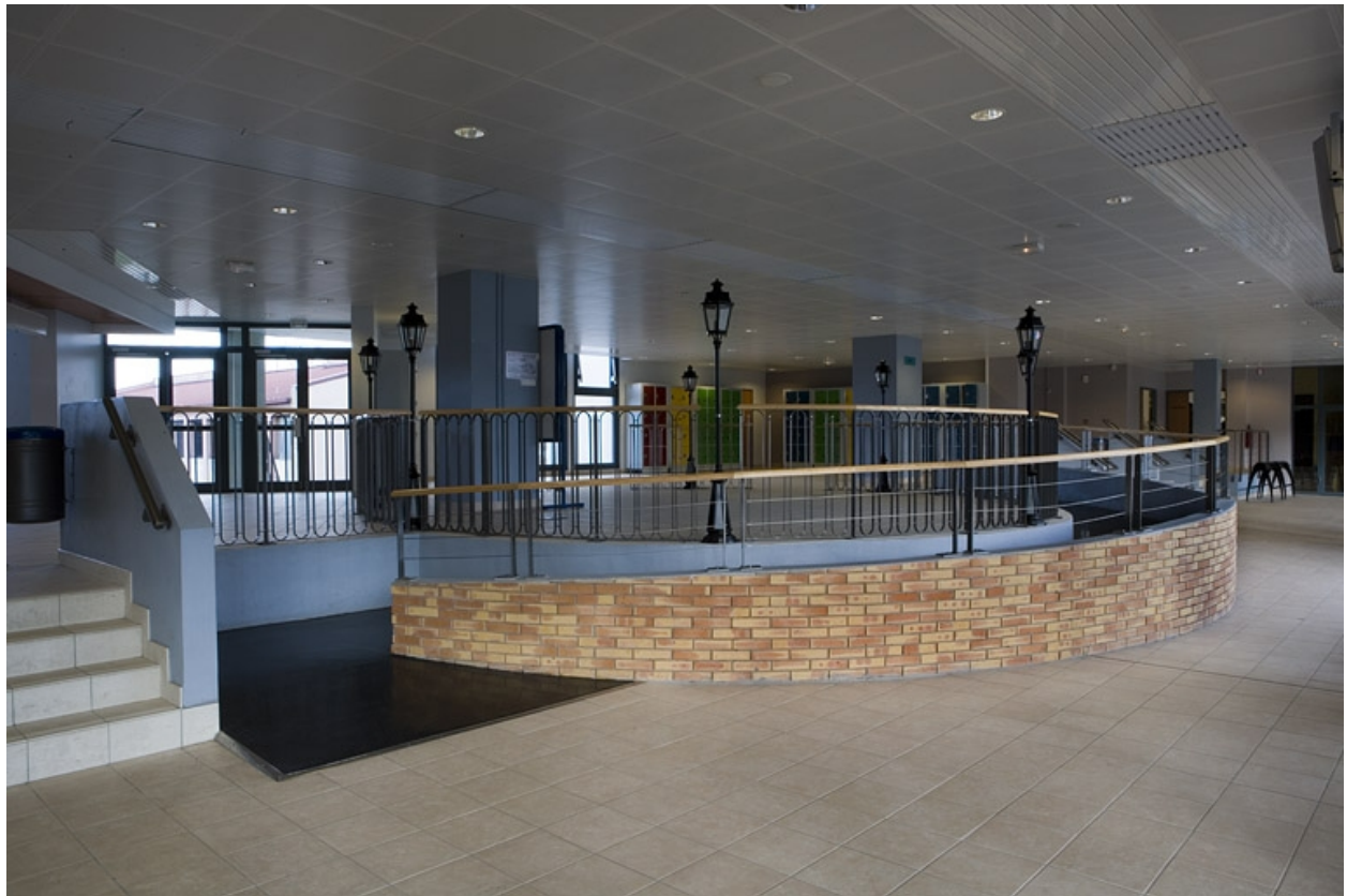
Bâtiment A. Vue du hall d'accueil. Détail.
