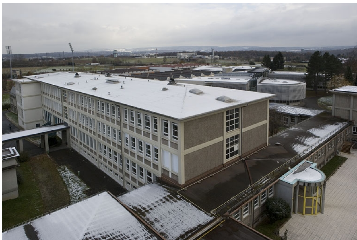
Vue d'ensemble depuis la tour d'internat.
