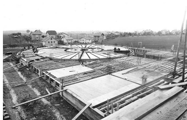
Vue du chantier de construction : la tour. Phot. Mary Ruffinoni IVR43_20152500276NUC1A
