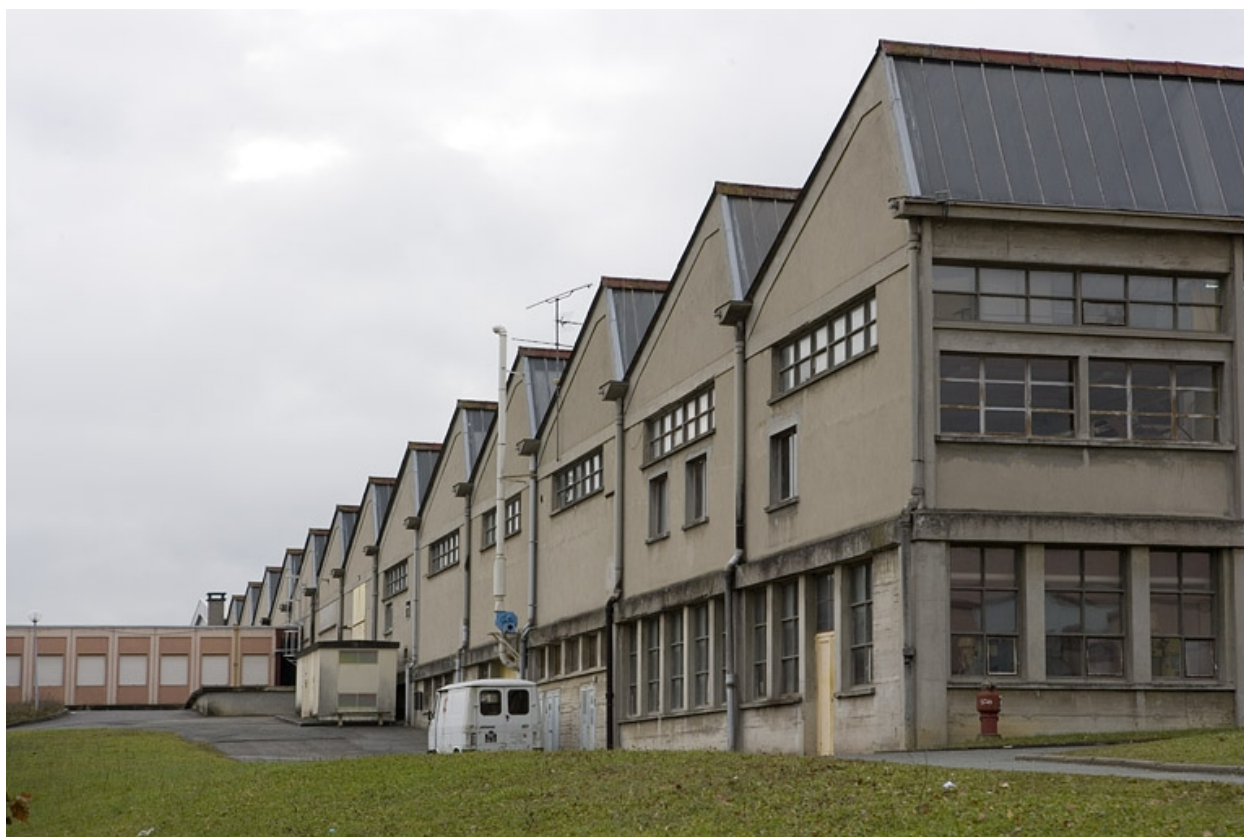
Vue de trois quarts droit bâtiment B.
