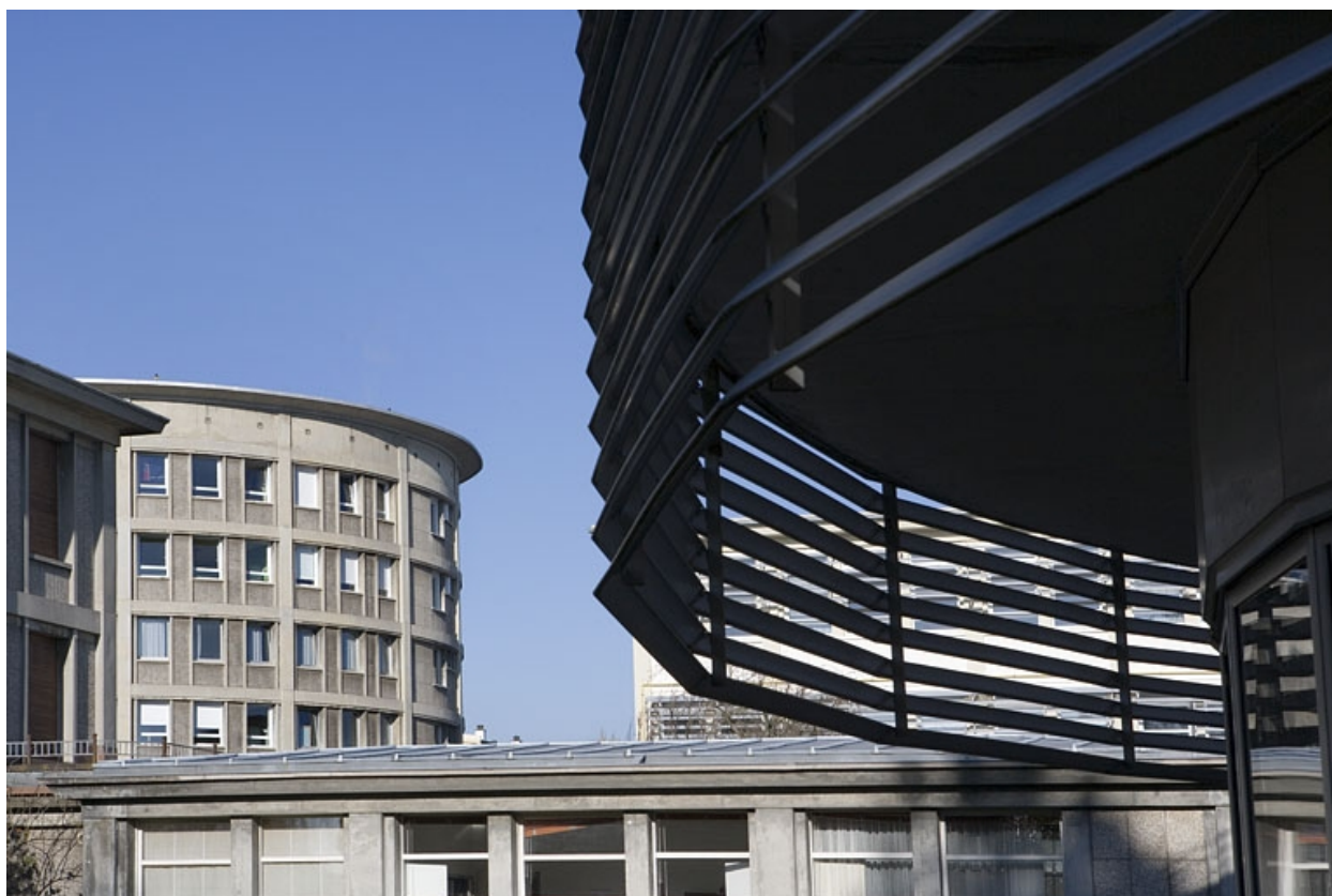
Détail architecture aile gauche bâtiment L.
