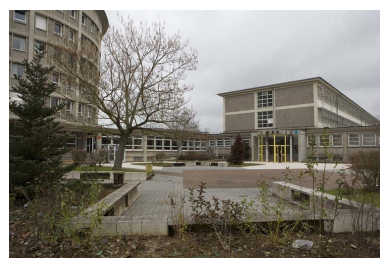
Vue entrée visiteurs. Phot. Yves Sancey IVR43_20072501005NUCA
