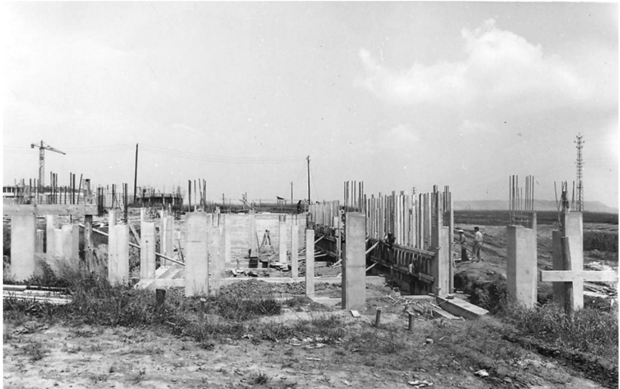
Vue du chantier de construction.
