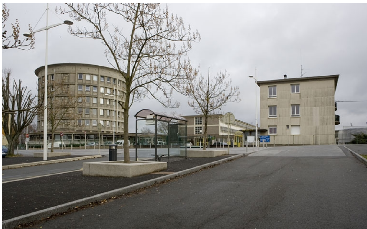
Vue d'ensemble côté entrée.
