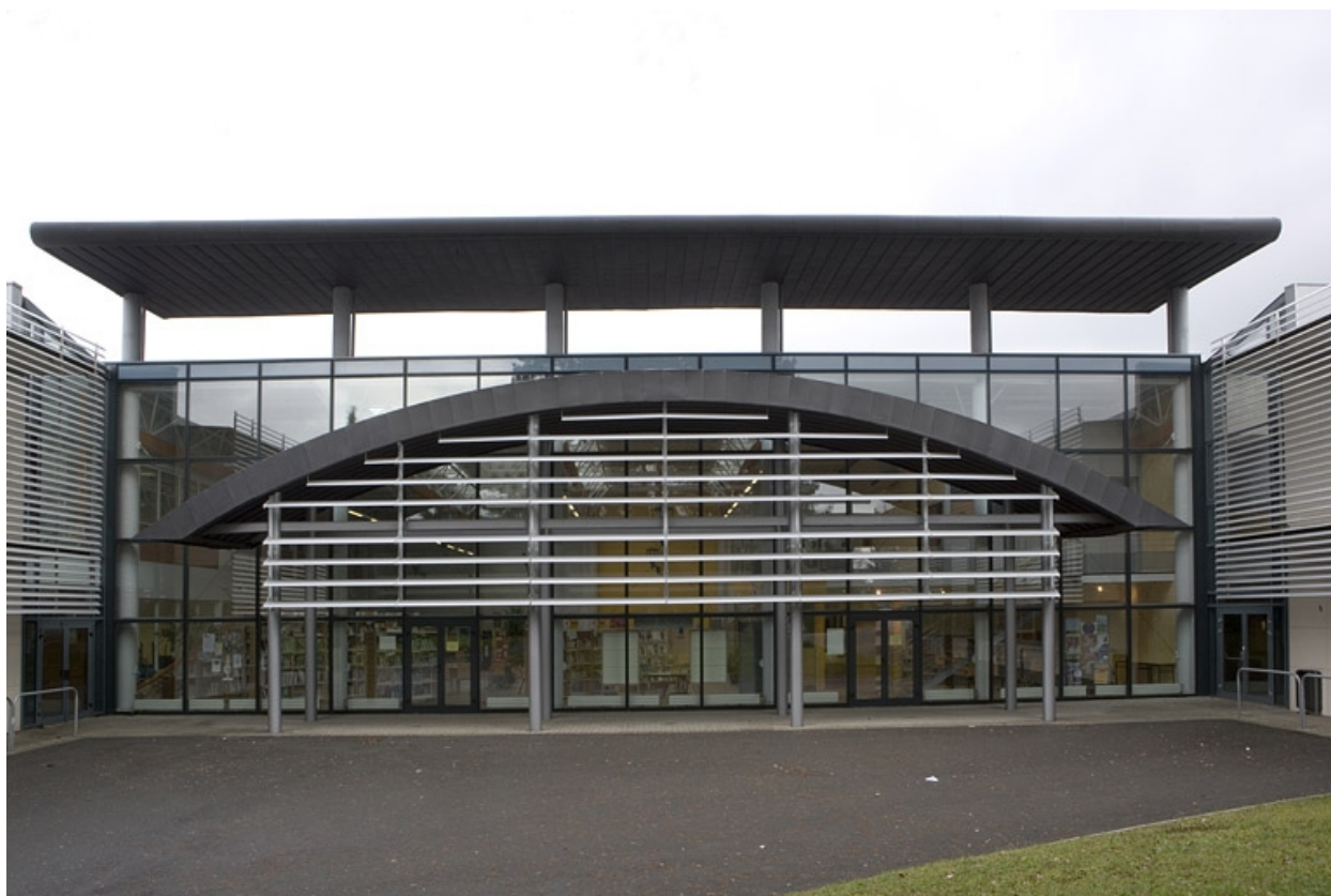
Vue façade antérieure bâtiment L.
