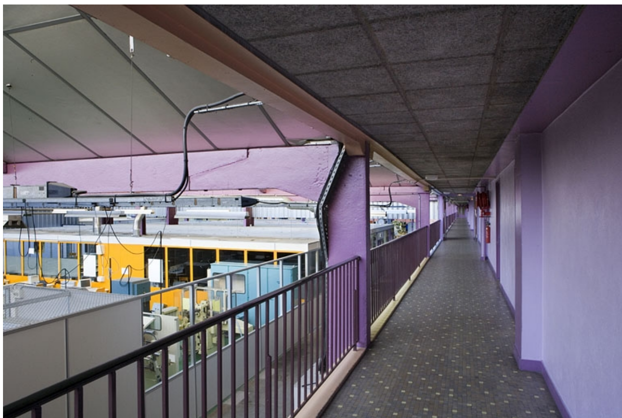
Bâtiment B. Atelier section technologique. Vue passerelle.
