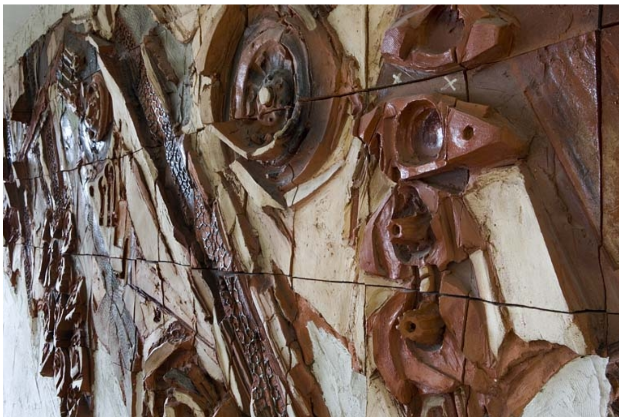
Bâtiment D. Détail haut-relief de Martine Planchat.
