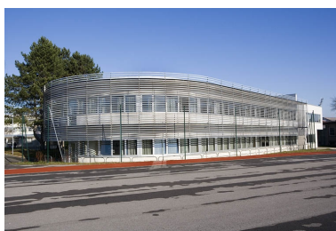
Vue de l'aile droite bâtiment L.
