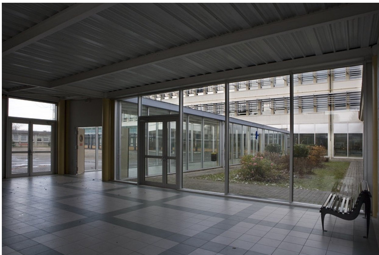
Couloir entre bâtiment A et B.
