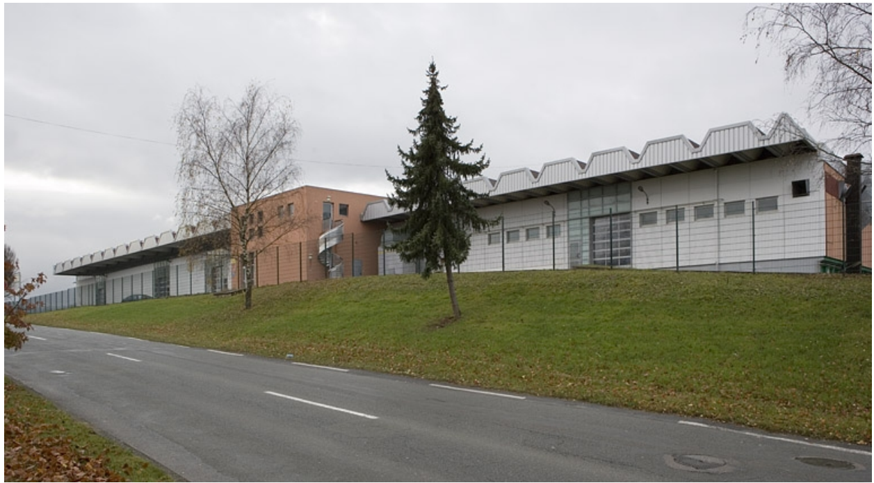
Vue façade postérieure bâtiment F.
