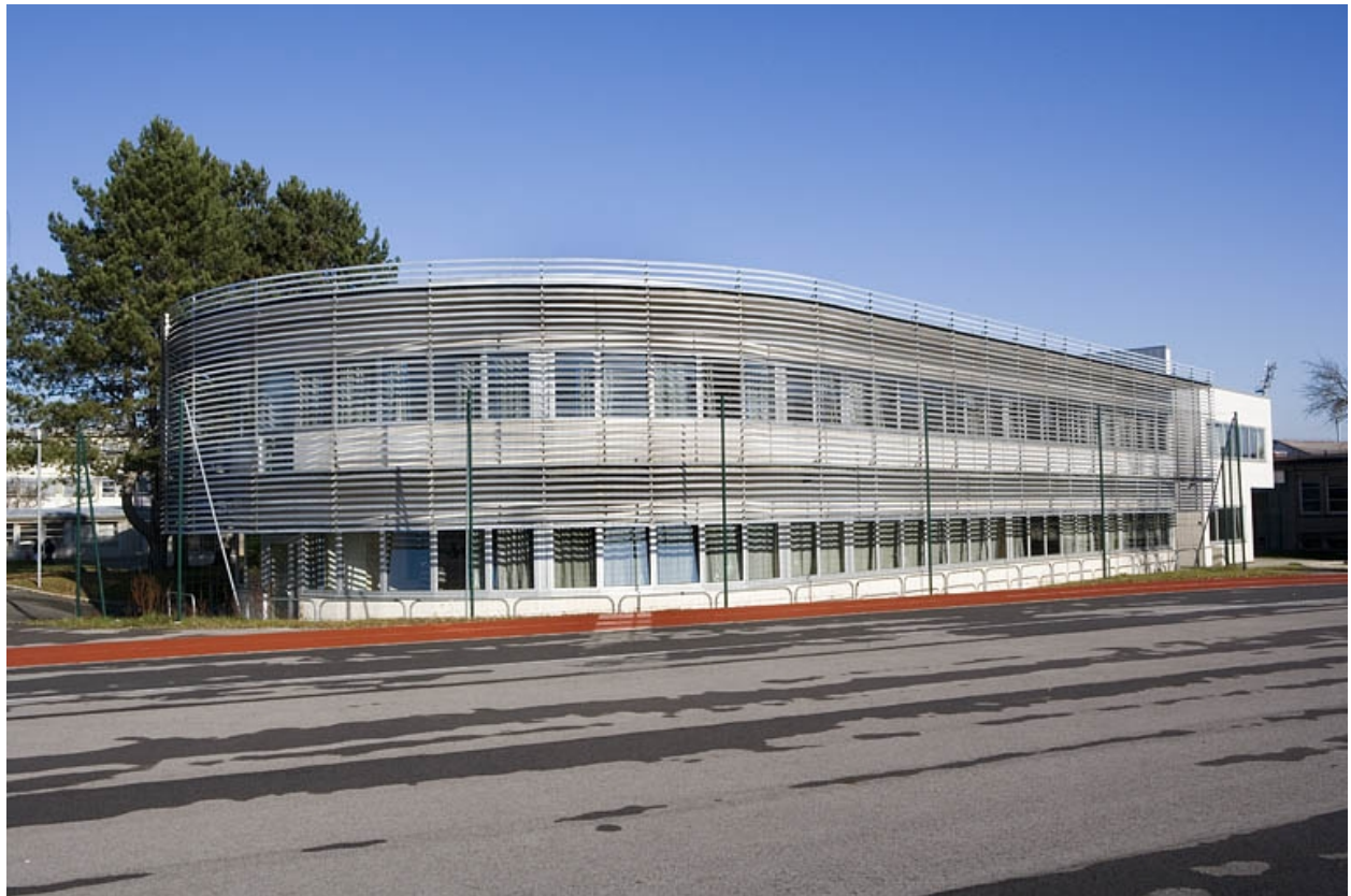
Vue de l'aile droite bâtiment L.
