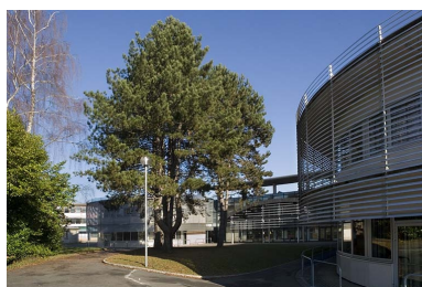
Vue de trois quarts droit bâtiment L.
