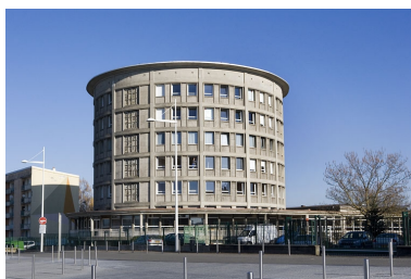
Bâtiment D. Tour internat. Phot. Yves Sancey IVR43_20072501014NUCA
