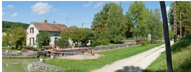
Vue d'ensemble du site d'écluse.
