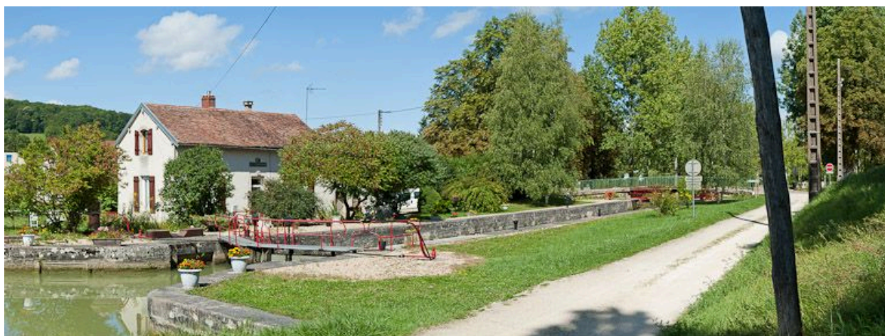
Vue d'ensemble du site d'écluse.
