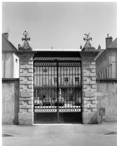
Détail du portail d'entrée, grille fermée. Phot. Yves Sancey IVR43_19917000026X
