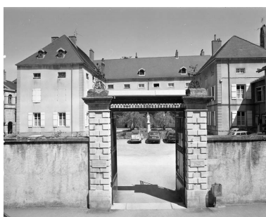
Vue d'ensemble depuis la rue. Phot. Yves Sancey IVR43_19917000024X
