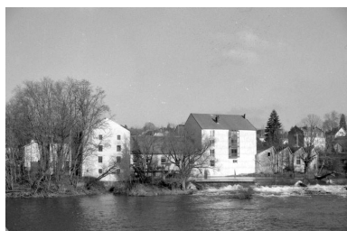
Vue d'ensemble depuis le sud, en 1990. Phot. Laurent Poupard IVR43_19903900702Z
