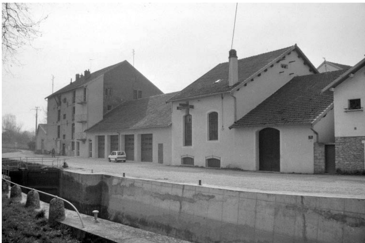
Façade antérieure vue de l'ouest.
