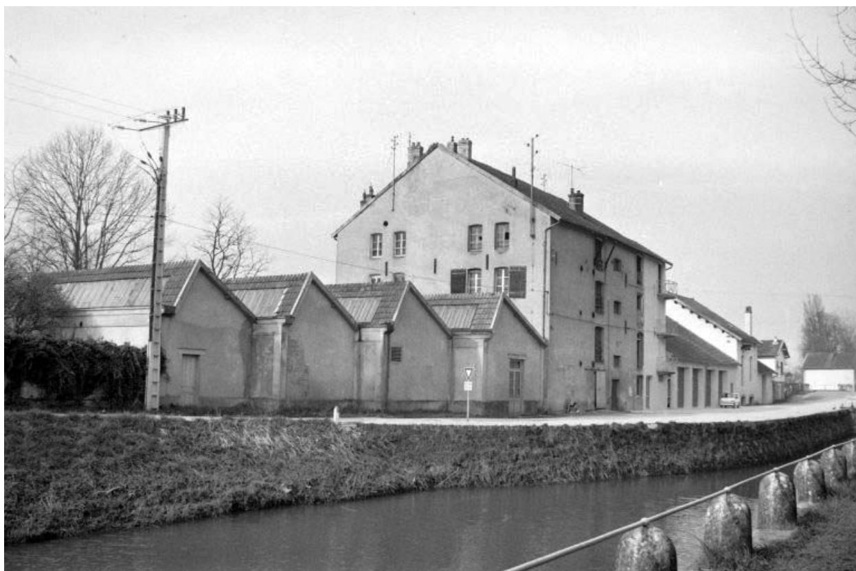
Façade antérieure vue de l'est.
