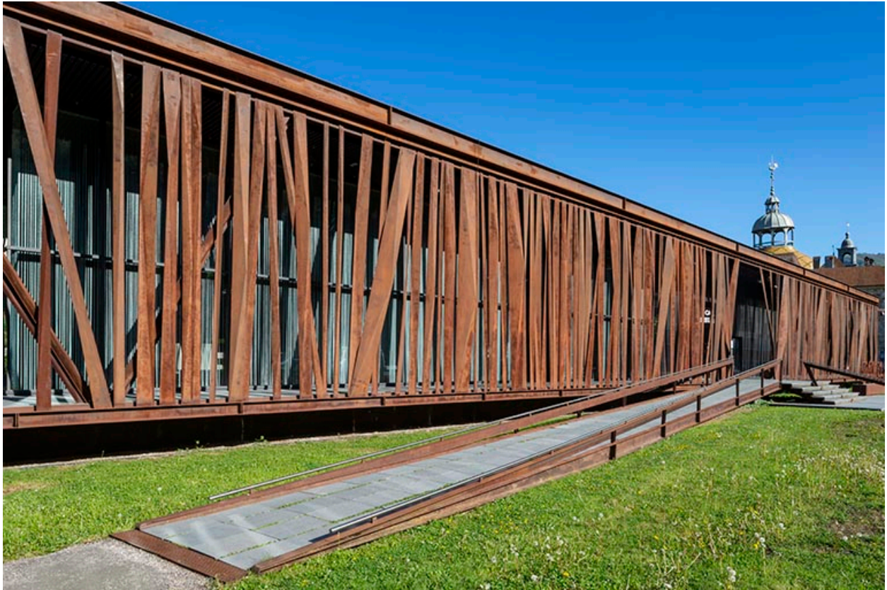
Vue depuis le sud-est.
