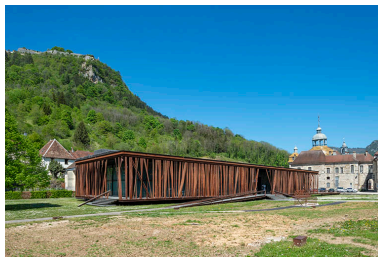
Vue d'ensemble de l'édifice surplombé par le fort Saint-André. Phot. Jérôme Mongreville IVR43_20223900418NUC4A
