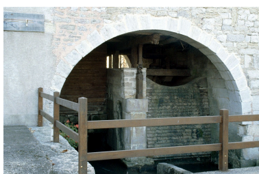
Chambre d'eau de la turbine, depuis l'aval. Phot. Laurent Poupard IVR43_19883900642ZA
