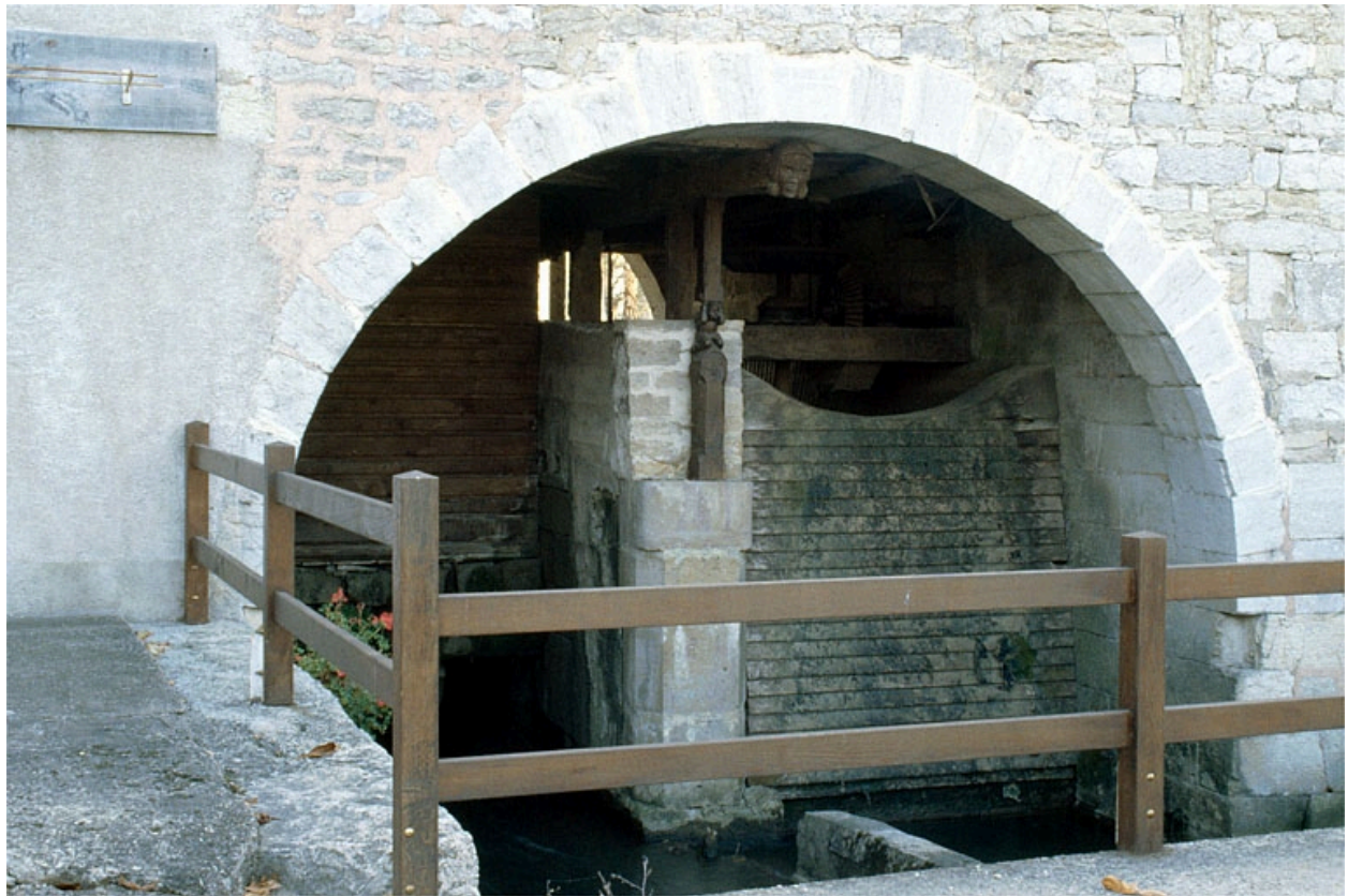
Chambre d'eau de la turbine, depuis l'aval.
