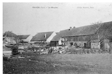
Rahon (Jura) - Le Moulin. Phot. Laurent Poupard, Austr. G. (photographe) Karrer IVR43_19883900633Z
