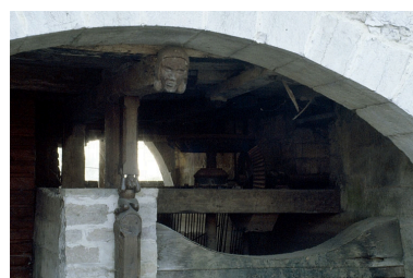
Pilier de soutènement sculpté et transmission de la turbine. Phot. Laurent Poupard IVR43_19883900643ZA
