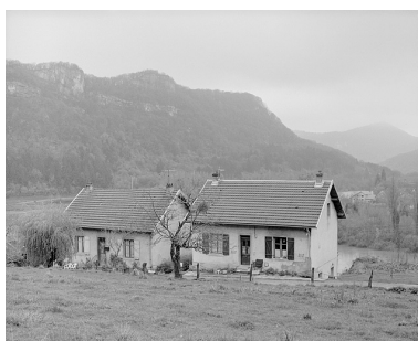
Vue d'ensemble des logements ouvriers individuels. Phot. Yves Sancey IVR43_20022500623X
