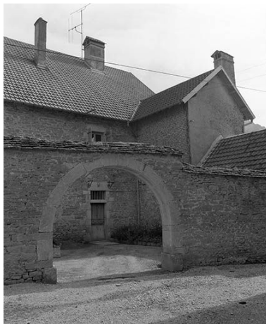
Détail de la façade antérieure : l'entrée. Phot. Yves Sancey IVR43_19802501149X
