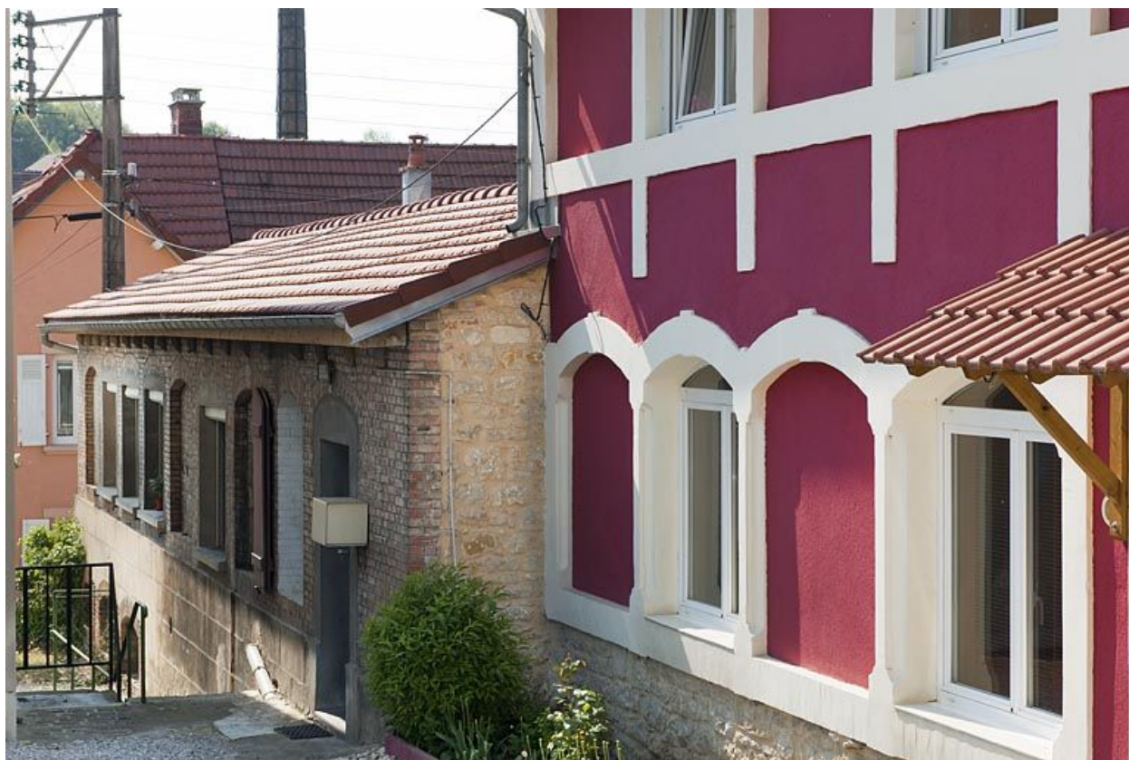
Façade sud des ateliers.
