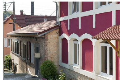
Façade sud des ateliers. Phot. Jérôme Mongreville IVR43_20112501399NUC4A
