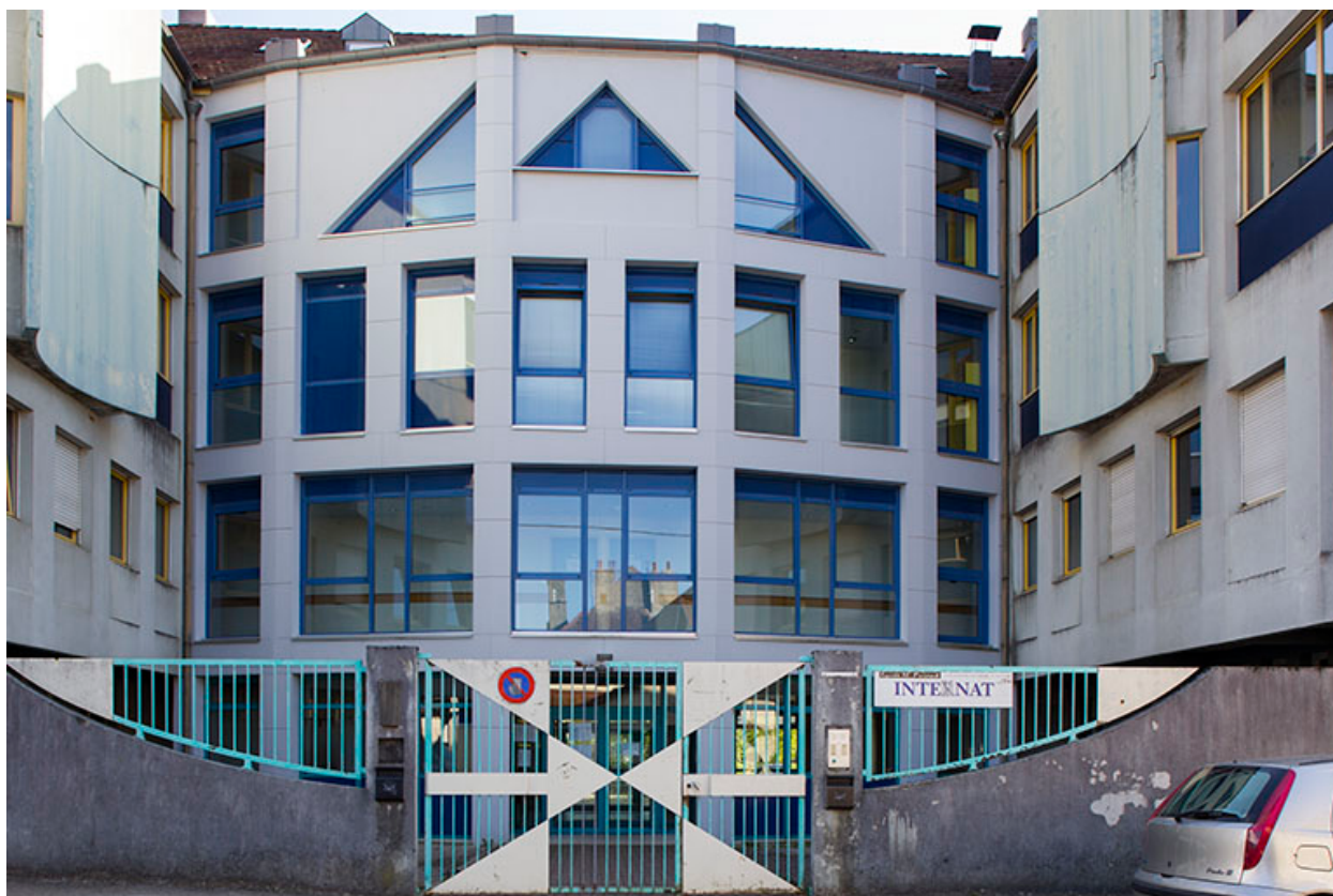
Internat : façade Nord, détail.
