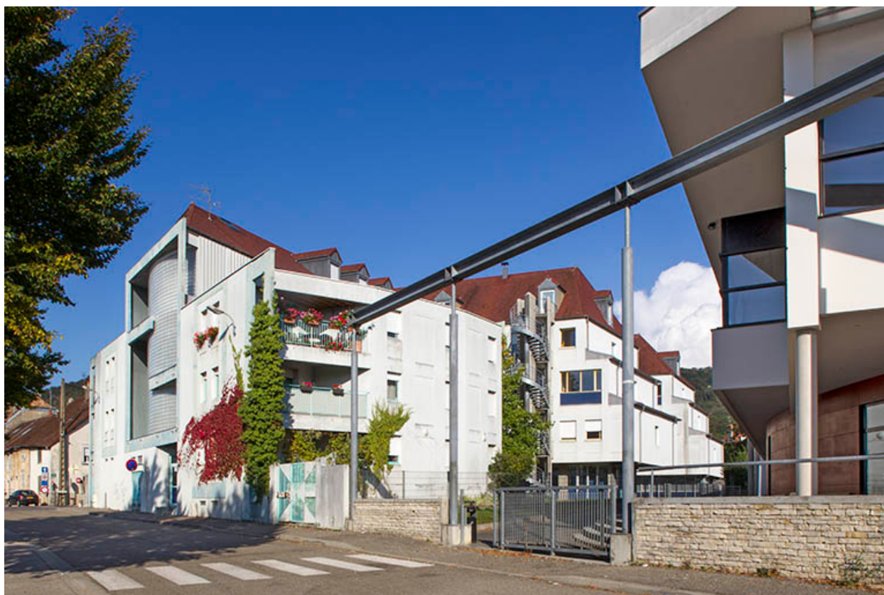
Internat : entrée, rue de Versailles.
