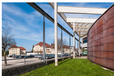
Restauration : entrée . Phot. Jérôme Mongreville IVR43_20143900096NUC4A
