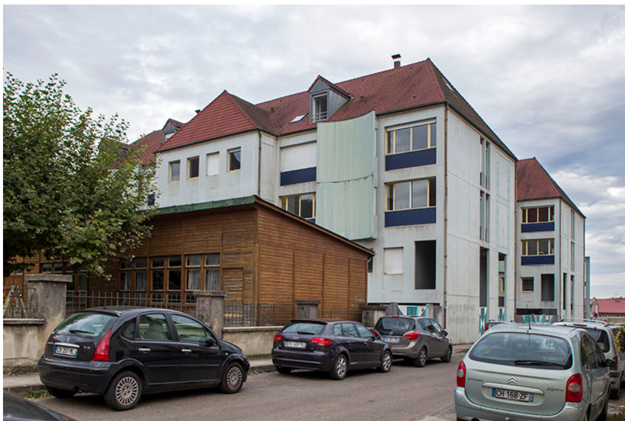
Internat : façades arrière.
