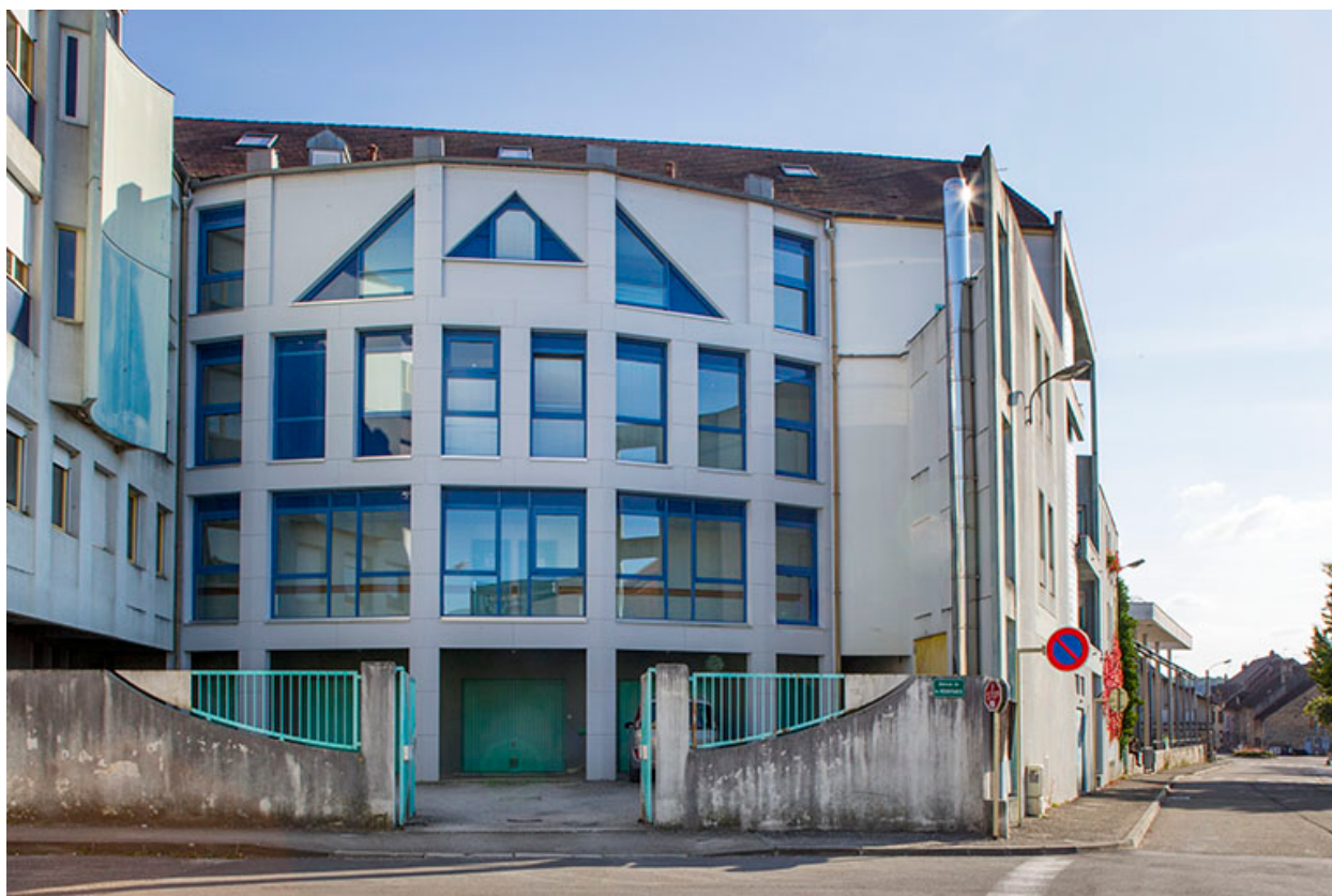
Internat : façades avec jeu des avant-corps.
