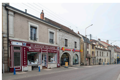
Vue actuelle du bas de la rue principale. Phot. Jérôme Mongreville IVR43_20177000461NUC4A
