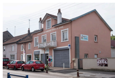
Ancienne station essence transformée en bureaux administratifs, rue F.Mitterrand. Phot. Jérôme Mongreville IVR43_20177000467NUC4A
