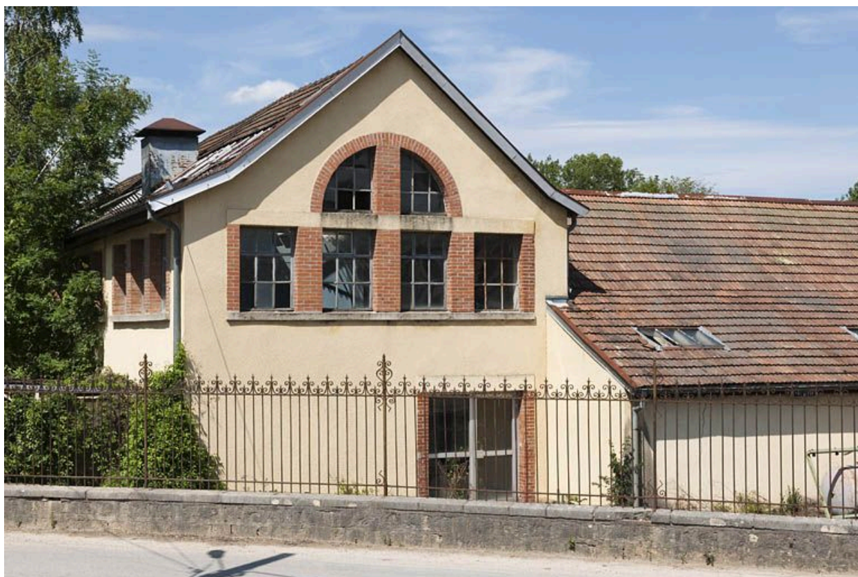
Pignon sud d'un bâtiment industriel (atelier).
