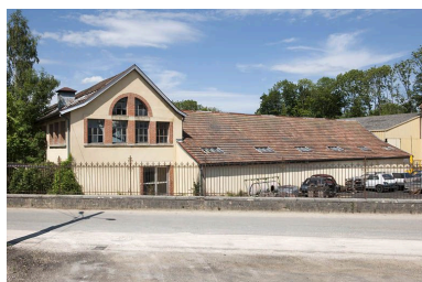
Atelier de fabrication (emboutissage, décolletage). Phot. Jérôme Mongreville IVR43_20112501173NUC4A
