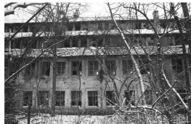
Façade occidentale de l'atelier d'horlogerie en 1979.
