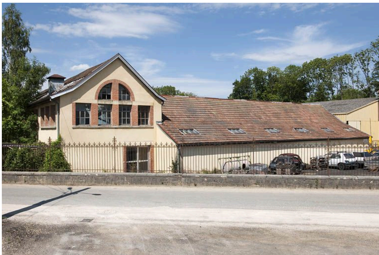
Atelier de fabrication (emboutissage, décolletage).
