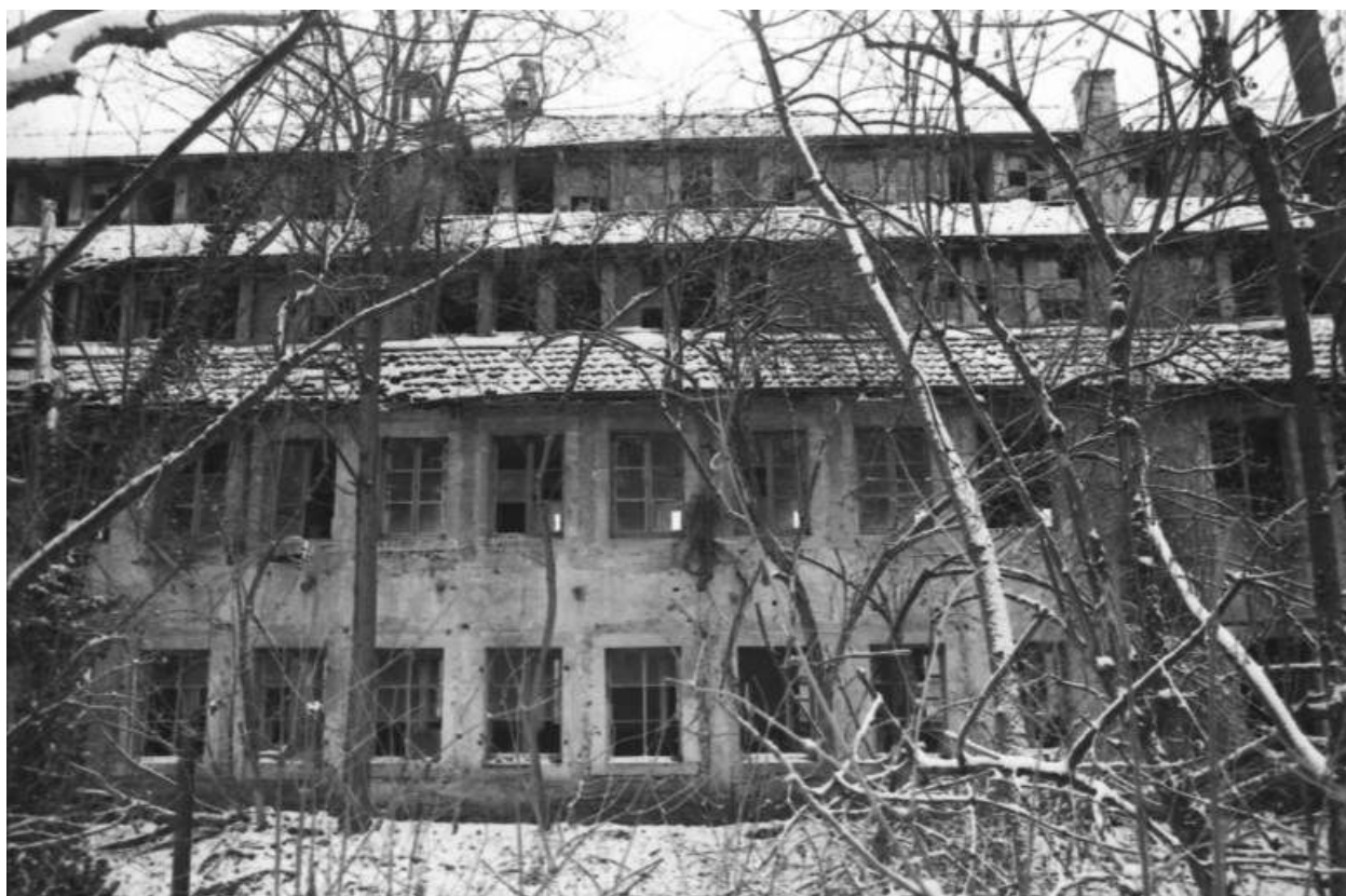
Façade occidentale de l'atelier d'horlogerie en 1979.
