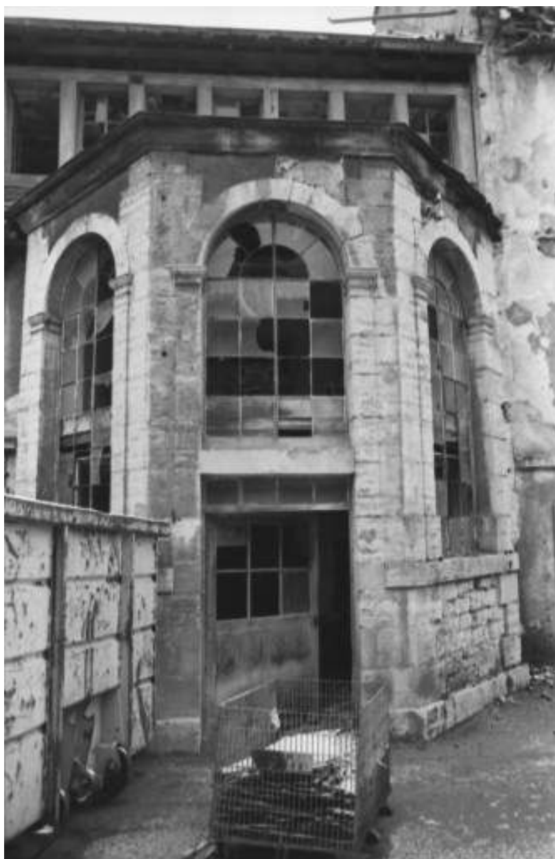
Atelier d'horlogerie. Détail de l'entrée en 1979.
