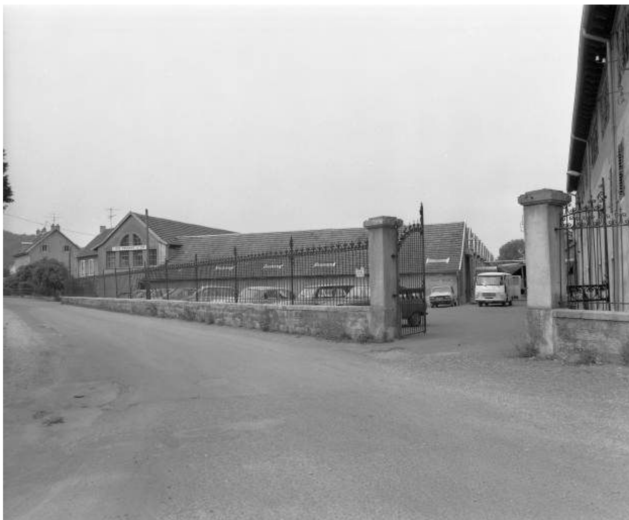
Ateliers en rez-de-chaussée depuis le sud en 1981.
