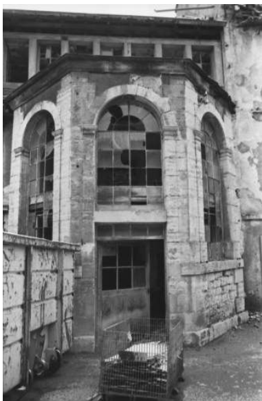
Atelier d'horlogerie. Détail de l'entrée en 1979.
