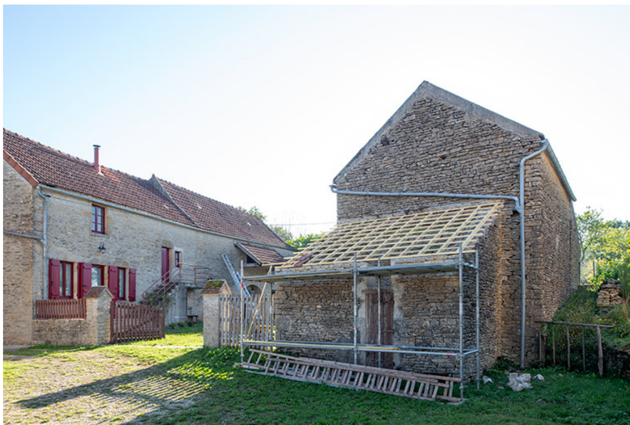
Le toit à porcs en travaux.
