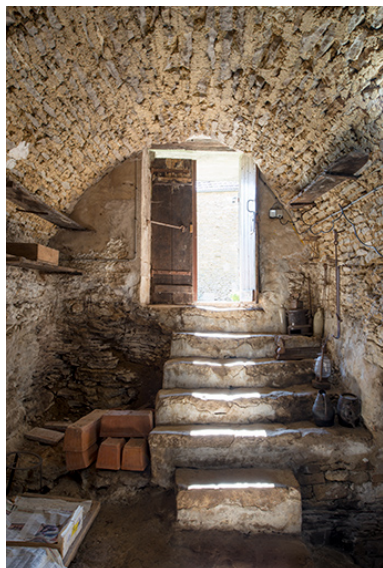
Le cellier est, depuis le fond. Phot. Nicolas Waltefaugle IVR26_20258900255NUC4A
