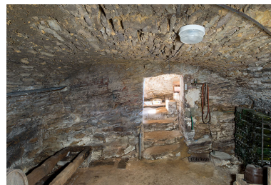
Le cellier ouest, depuis le fond. Phot. Nicolas Waltefaugle IVR26_20258900254NUC4A
