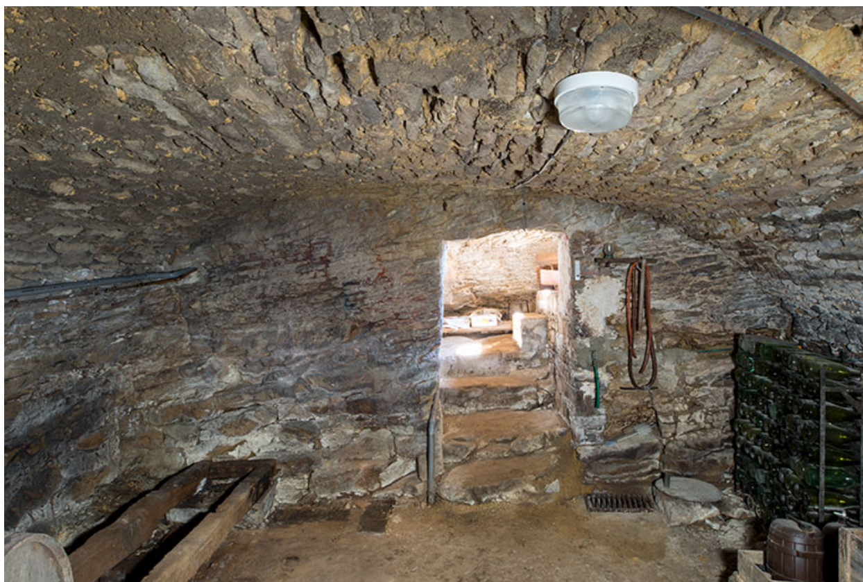
Le cellier ouest, depuis le fond.
