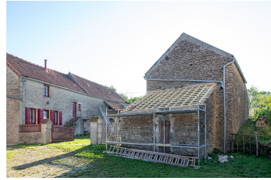
Le toit à porcs en travaux. Phot. Nicolas Waltefaugle IVR26_20258900231NUC4A
