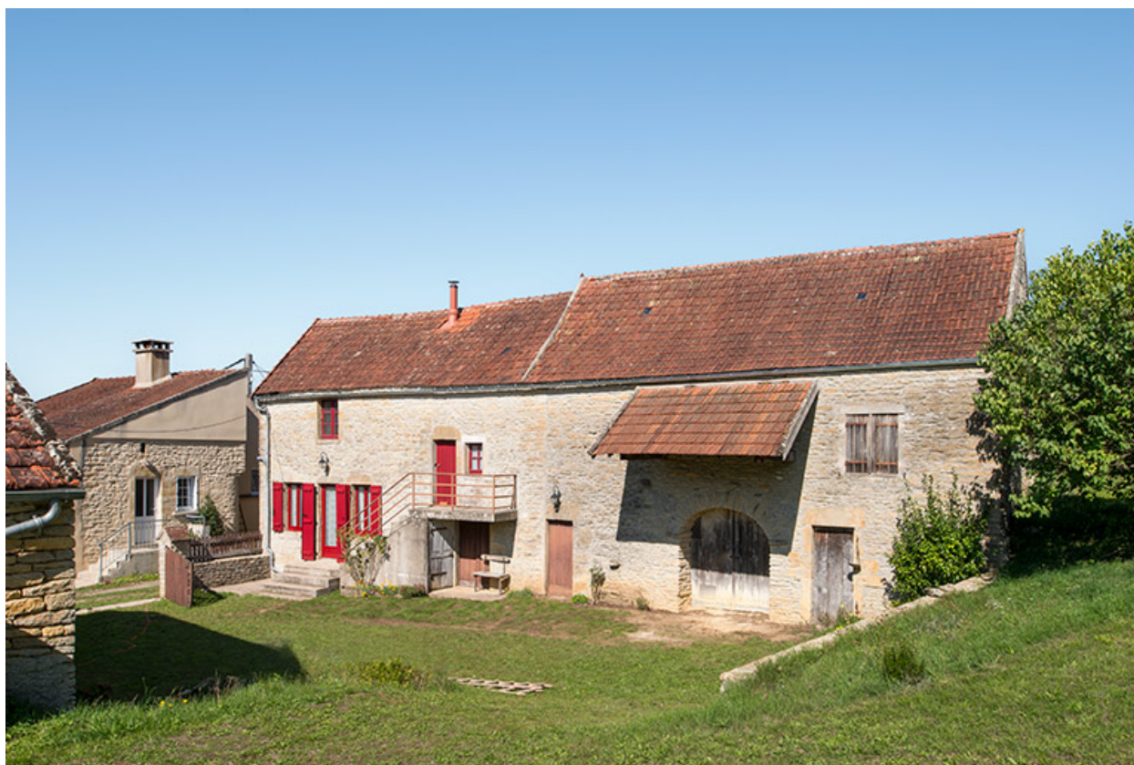
Le corps principal de la ferme, depuis l'est.
