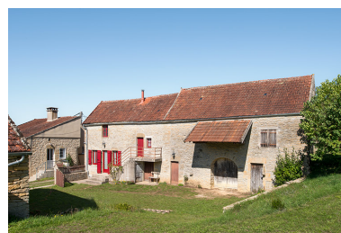
Le corps principal de la ferme, depuis l'est. Phot. Nicolas Waltefaugle IVR26_20258900252NUC4A
