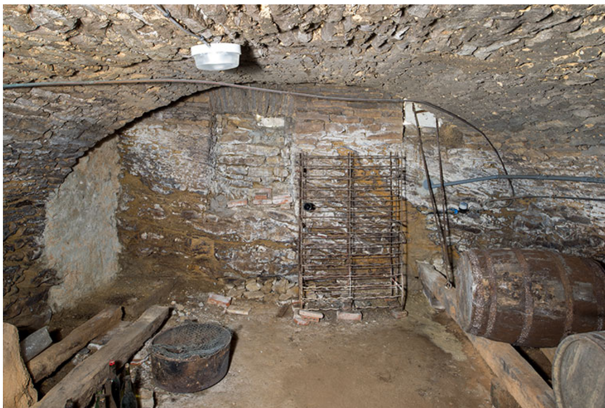
Le cellier ouest, depuis l'entrée.
