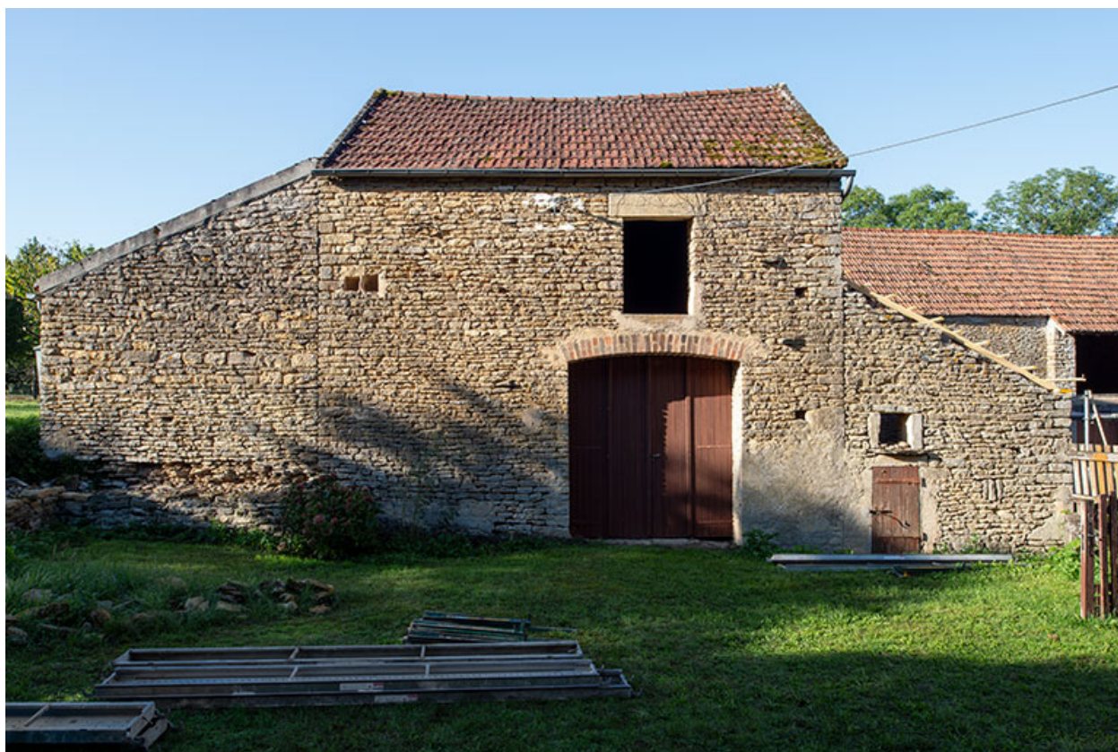
La grange secondaire depuis la cour.
