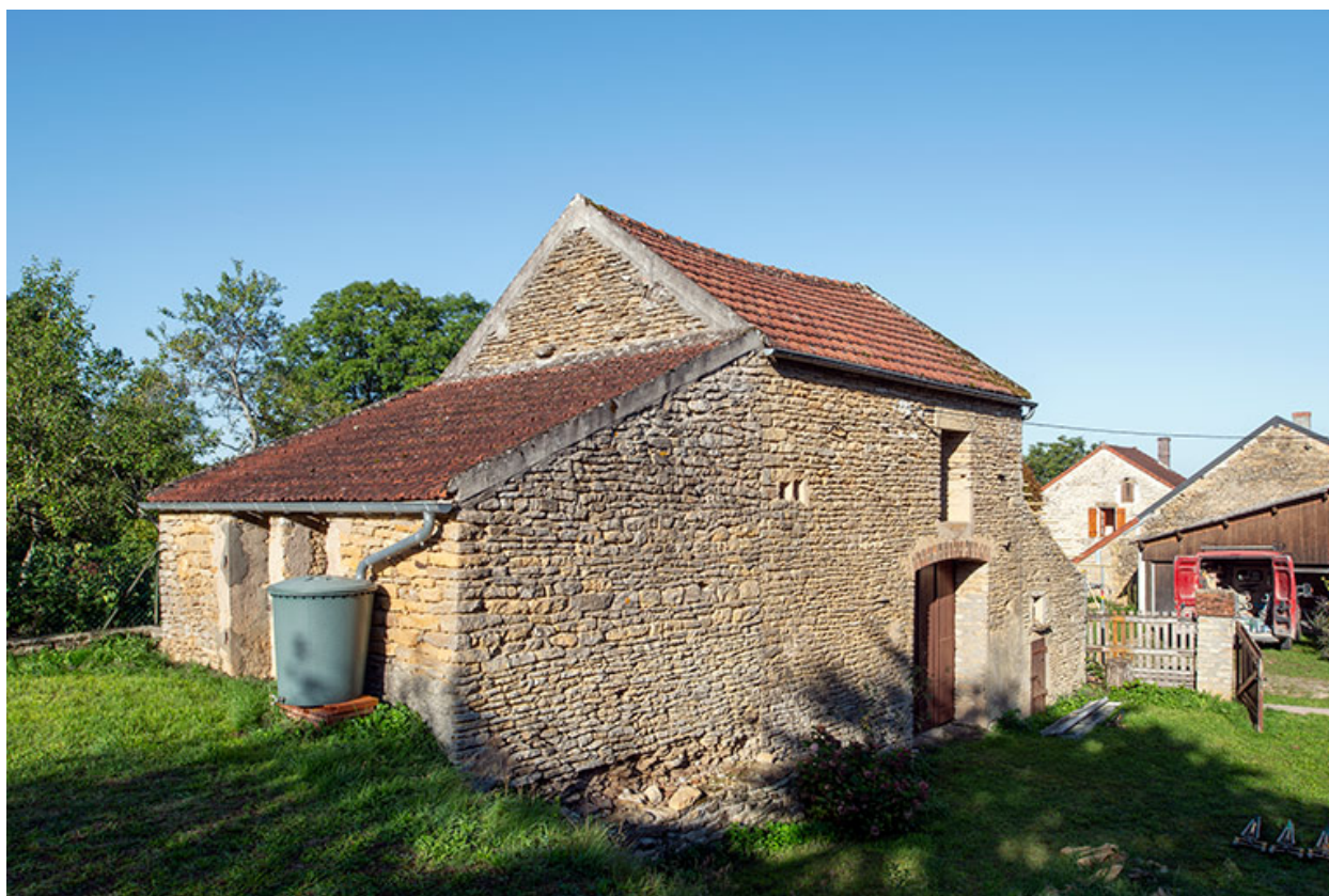
La grange secondaire vue de trois quarts.
