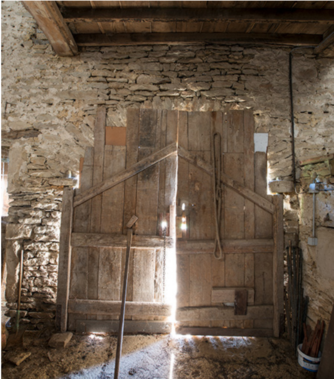
La porte charretière de la grange, de l'intérieur.
