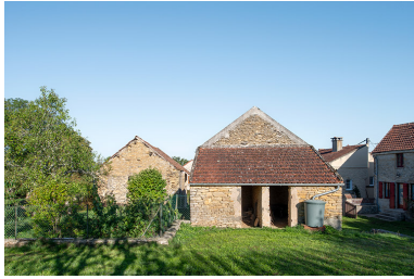
Le poulailler et le toit à porcs au sud. Phot. Nicolas Waltefaugle IVR26_20258900229NUC4A
