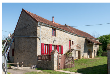
Le corps principal de la ferme vu depuis l'ouest. Phot. Nicolas Waltefaugle IVR26_20258900250NUC4A
