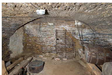
Le cellier ouest, depuis l'entrée. Phot. Nicolas Waltefaugle IVR26_20258900253NUC4A
