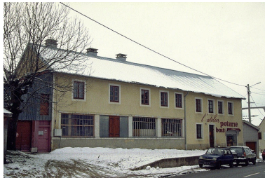
Façade antérieure. Phot. Laurent Poupard IVR43_19913901057ZA
