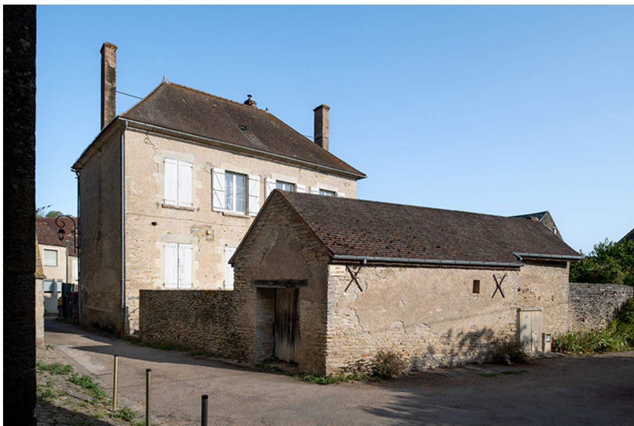
Façade postérieure depuis la ruelle de l'Église.
