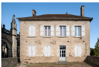
Façade postérieure. Phot. Nicolas Waltefaugle IVR26_20268900361NUC4A
