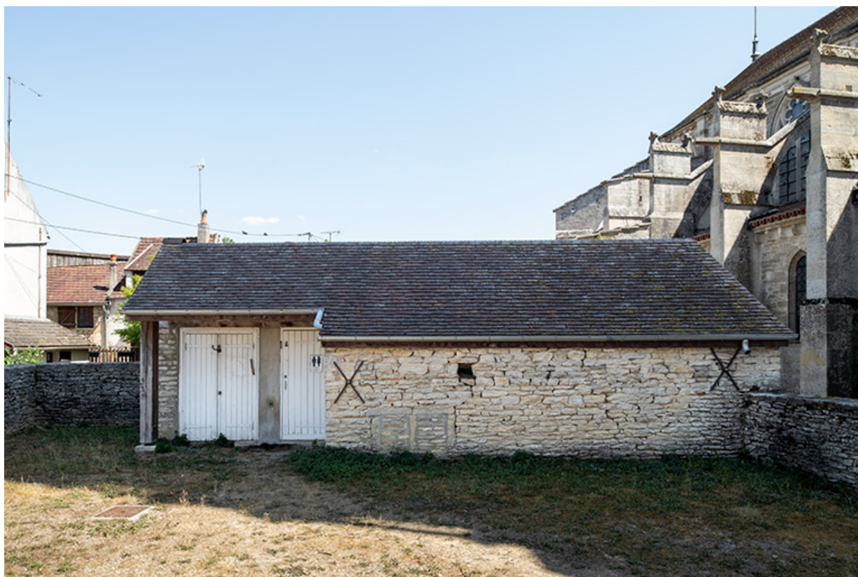
Annexe, vue de la cour.
