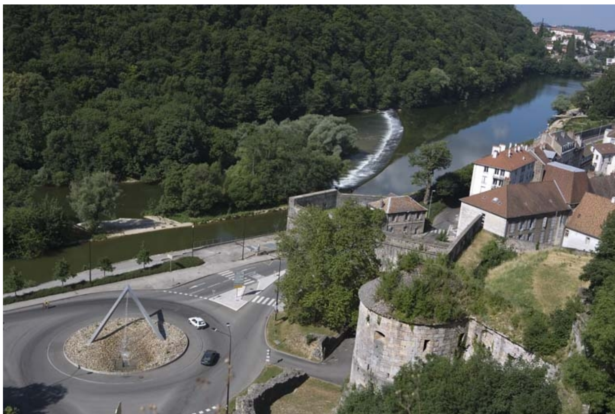
Vue d'ensemble plongeante sur le barrage.
