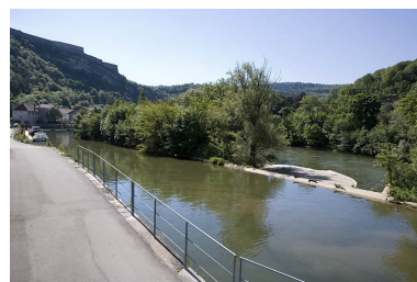
L'extrémité du barrage et le déversoir de superficie. Phot. Yves Sancey IVR43_20062500221NUCA
