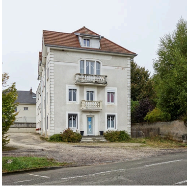
Vue depuis la rue. Phot. Fabien Dufoulon IVR43_20217000198NUC2A
