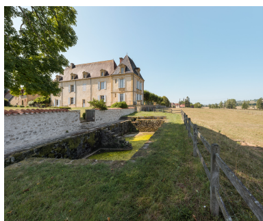
Vue de trois-quart de la façade postérieure du chateau, et des bassins d'irrigation des prés sous-jacents. Phot. Pierre-Marie Barbe-Richaud IVR26_20187100350NUC4AQ
