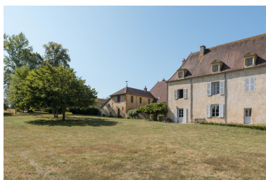
Vue d'ensemble des façades orientales postérieures. Phot. Pierre-Marie Barbe-Richaud IVR26_20187100348NUC4A
