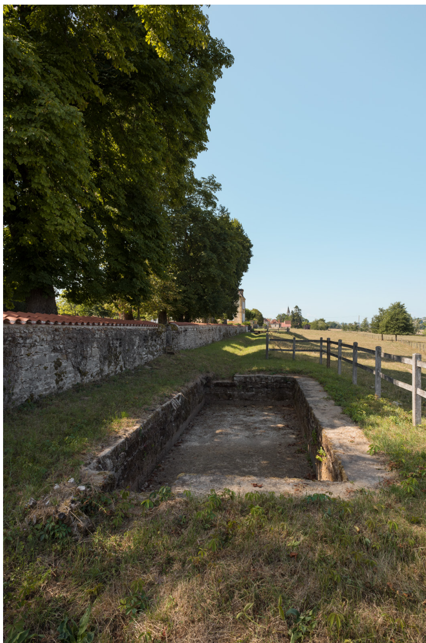
Bassin d'irrigation des prés sous-jacents.
