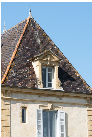
Vue de détail du pavillon nord-ouest vu de l'est. Phot. Pierre-Marie Barbe-Richaud IVR26_20187100347NUC4A
