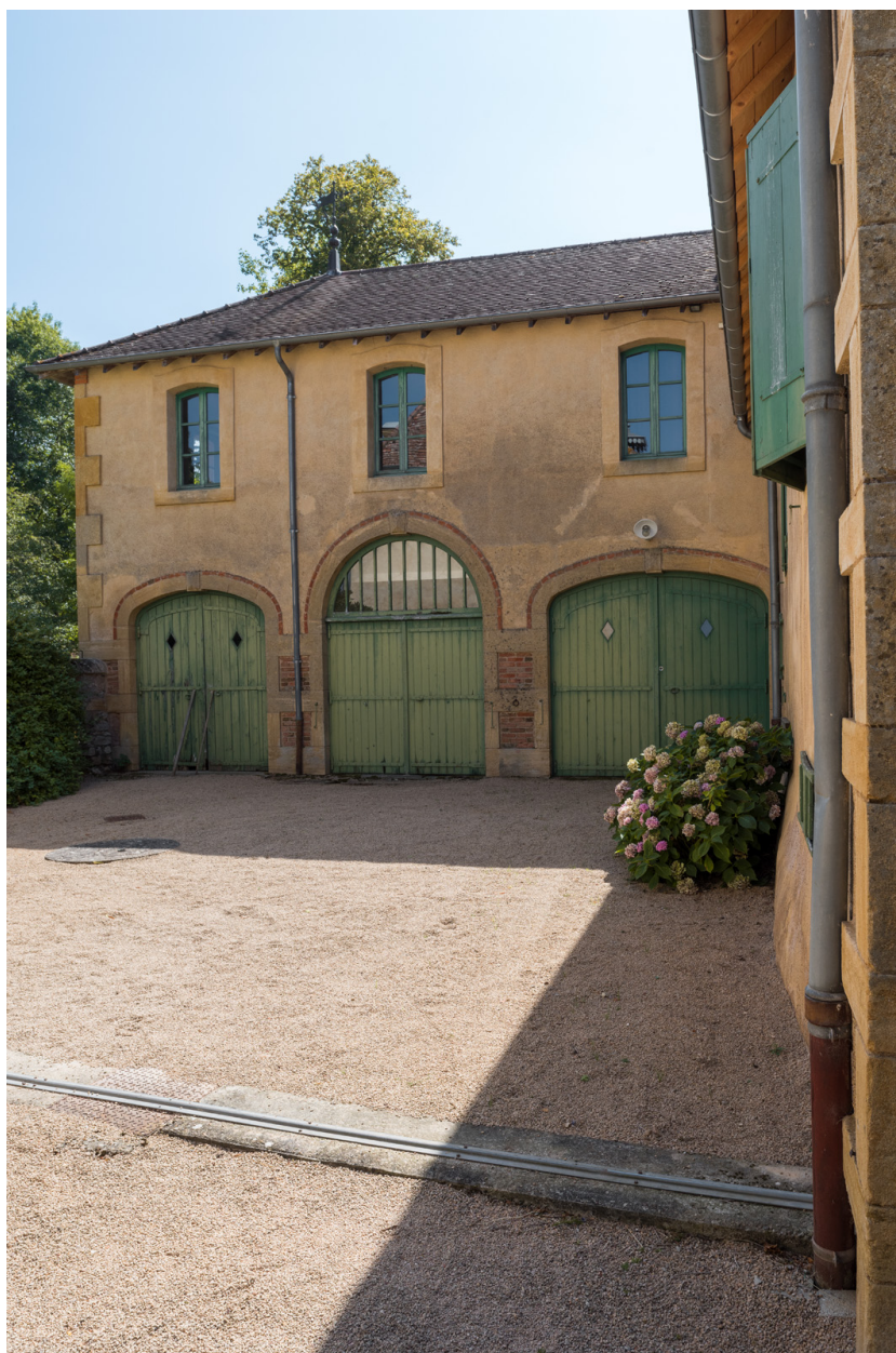
Vue de l'aile nord-est des dépendances agricoles : façade nord-ouest à trois portes.
