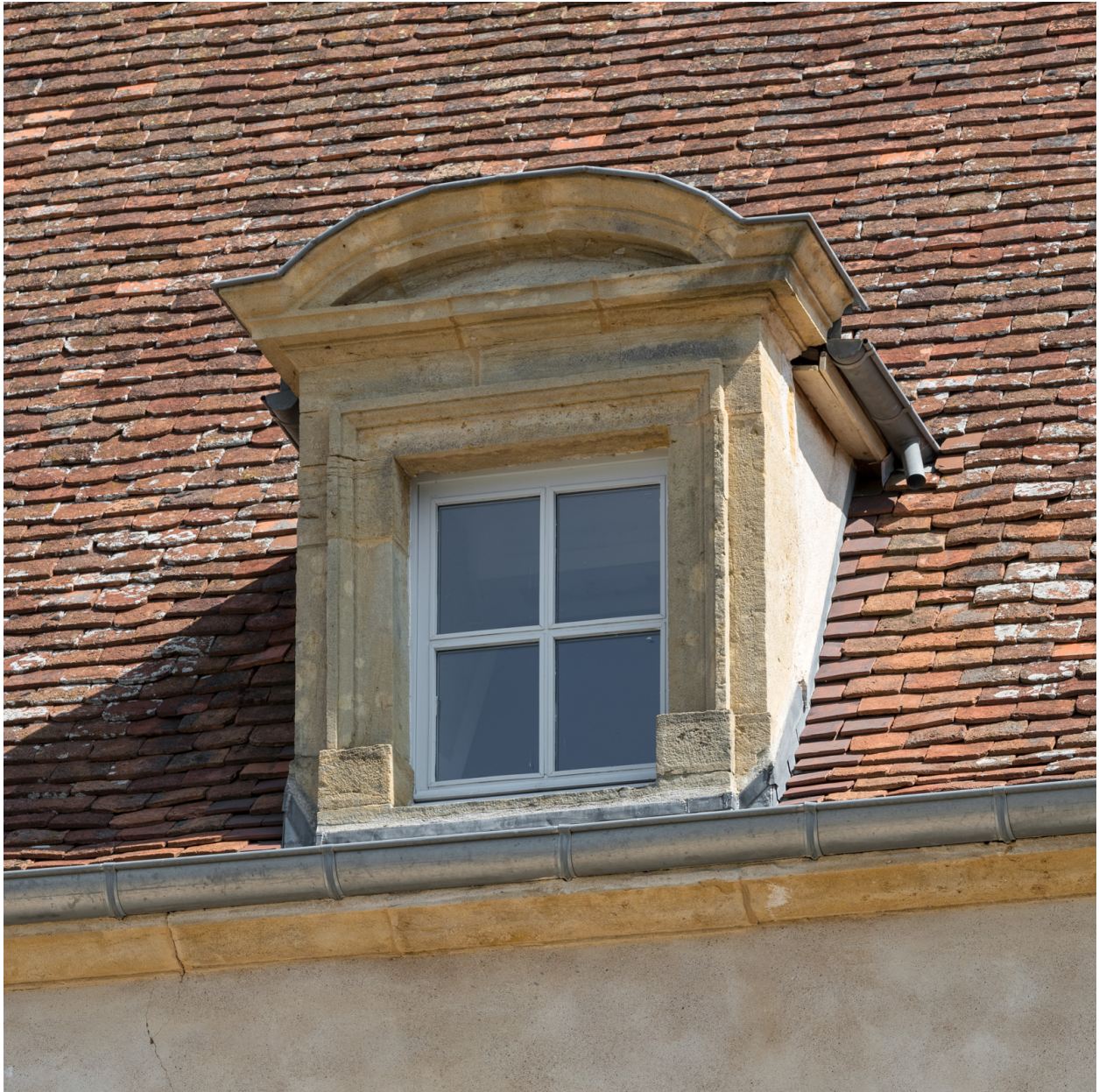
Vue rapprochée de la lucarne centrale sur la façade antérieure.
