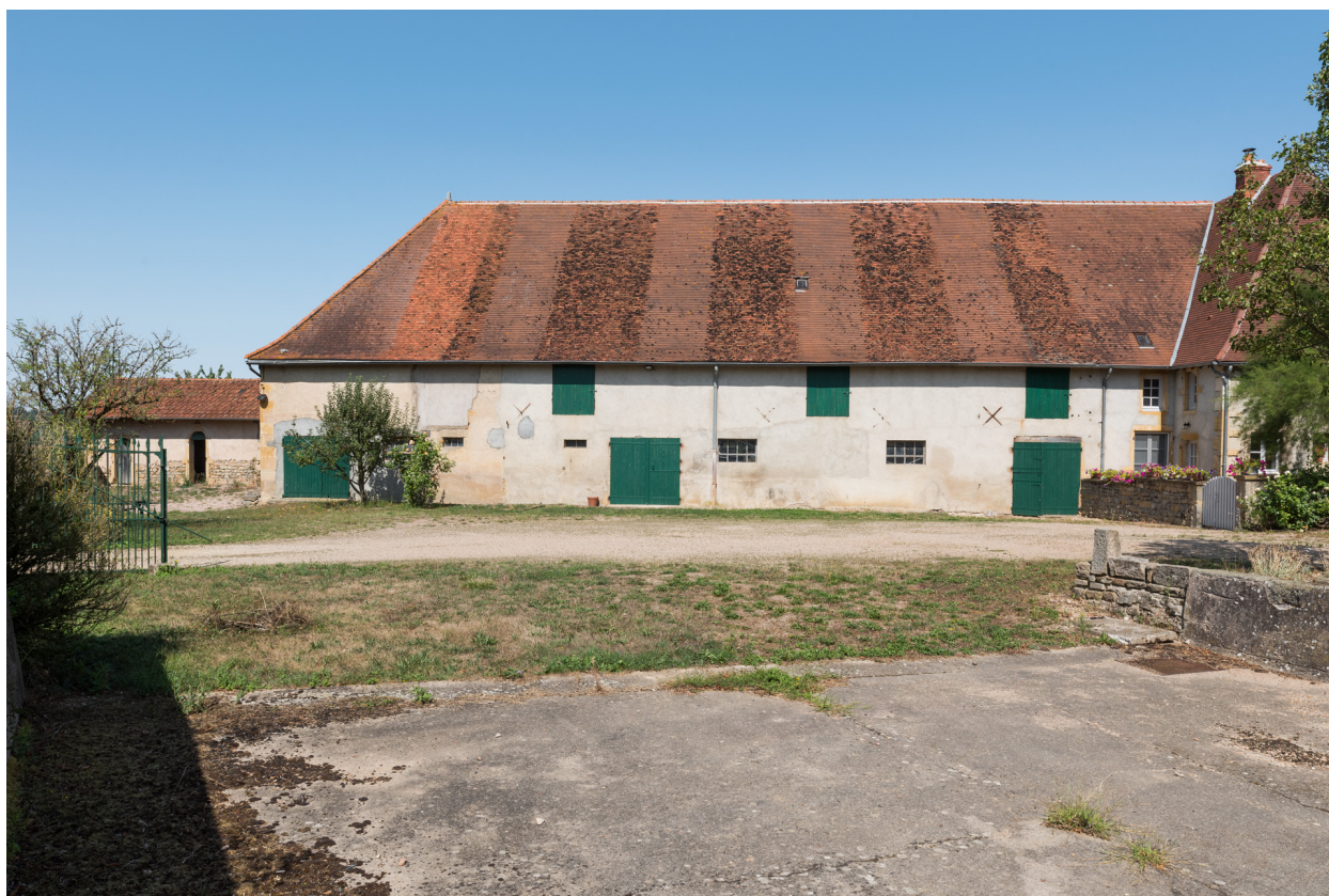
Facade postérieure (sud-est) de la ferme.
