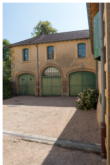
Vue de l'aile nord-est des dépendances agricoles : façade nord-ouest à trois portes. Phot. Pierre-Marie Barbe-Richaud IVR26_20187100337NUC4A
