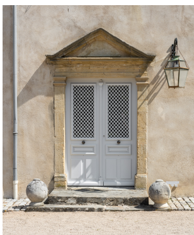
La porte d'entrée sur la façade antérieure : vue rapprochée. Phot. Pierre-Marie Barbe-Richaud IVR26_20187100332NUC4A
