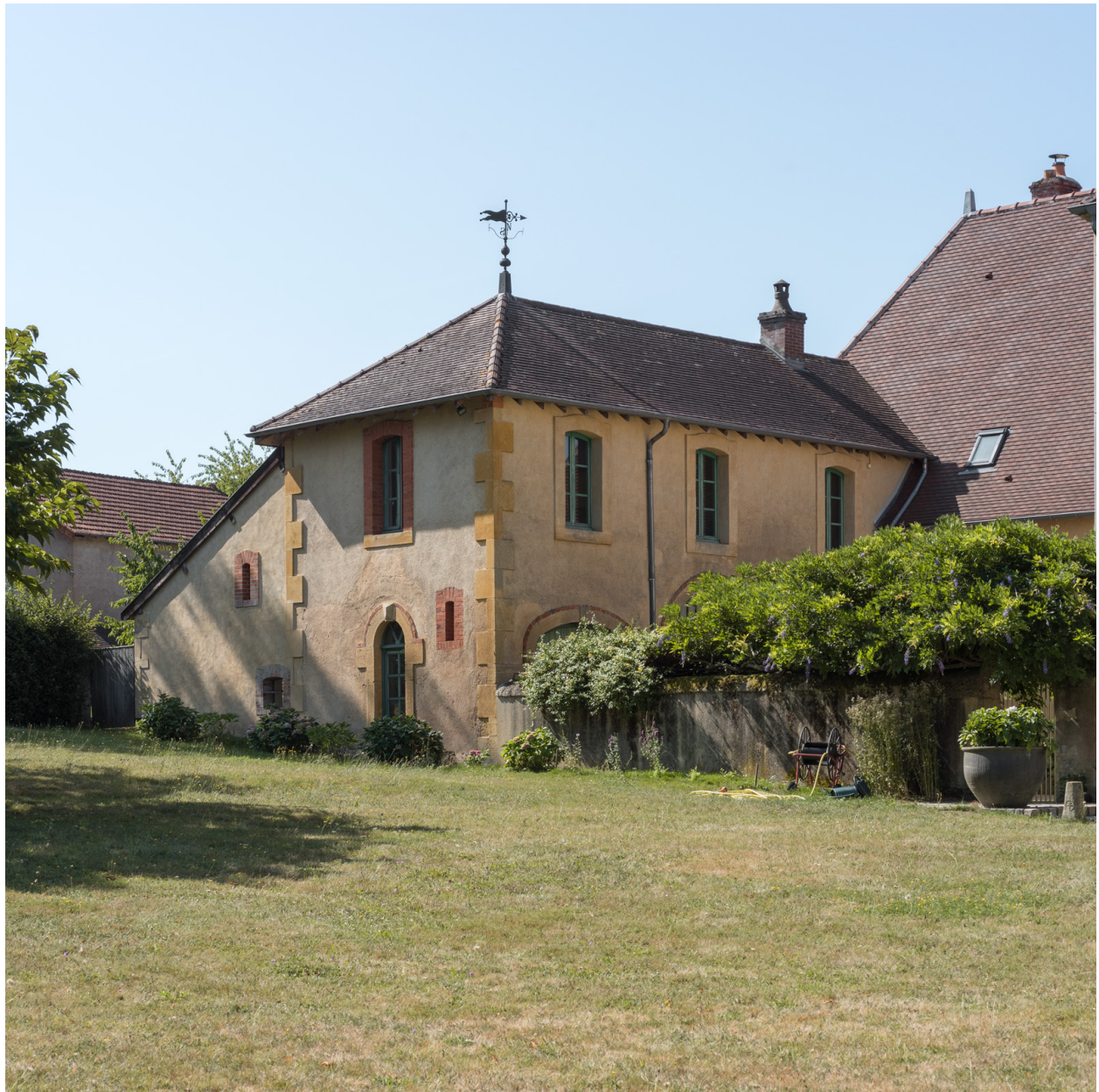
Vue rapprochée de trois-quart de la façade orientale de la dépendance.
