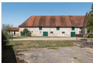
Facade postérieure (sud-est) de la ferme. Phot. Pierre-Marie Barbe-Richaud IVR26_20187100339NUC4A
