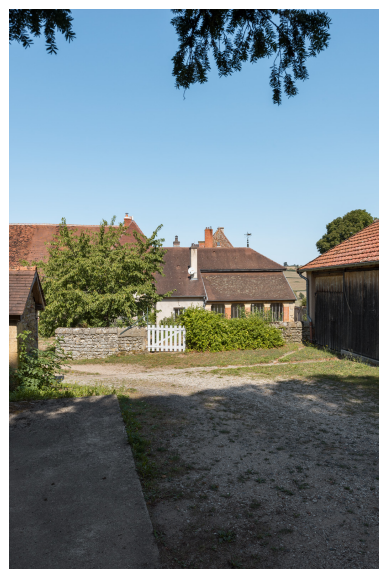
Vue d'ensemble sur les édifices au sud-est du château et le jardin d'hiver. Phot. Pierre-Marie Barbe-Richaud IVR26_20187100341NUC4A
