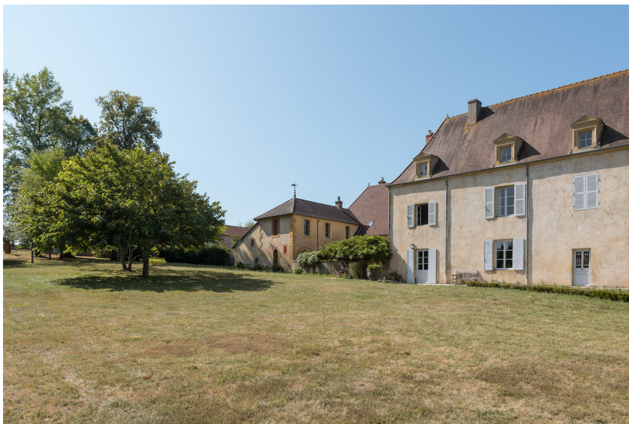
Vue d'ensemble des façades orientales postérieures.
