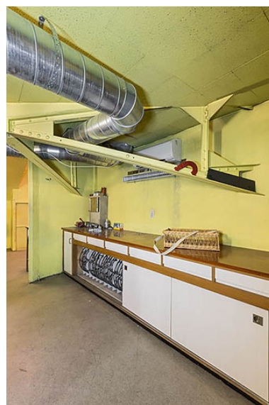
Meuble de stockage des bobines de films.
