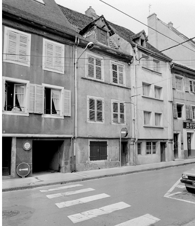
Façade sur rue. Phot. Jérôme Mongreville IVR43_19872500774X
