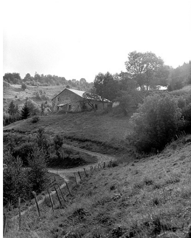
Vue de la ferme dans le paysage. Phot. Jérôme Mongreville IVR43_19943900857X
