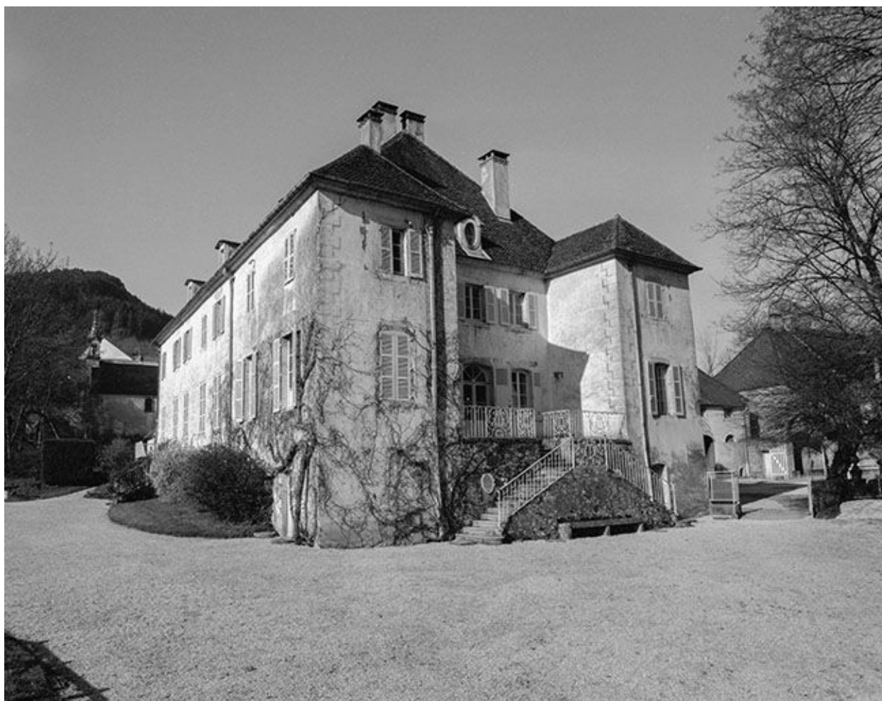
Logis : façade nord.
