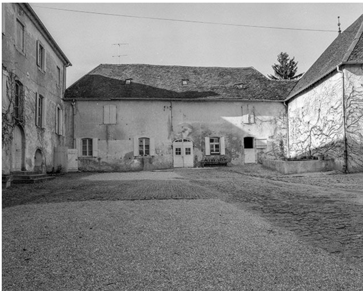
Les communs : façade sur cour.
