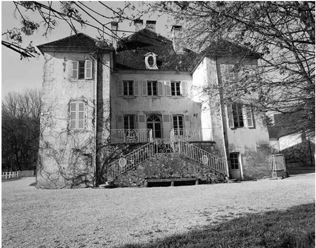
Logis : façade nord.
