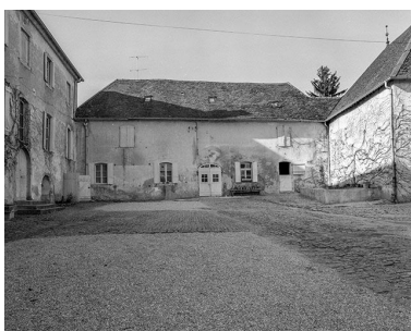
Les communs : façade sur cour. Phot. Jérôme Mongreville IVR43_19853900107X
