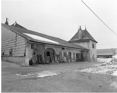
Façade sur rue. Phot. Dominique Dominguez IVR43_19802500095X
