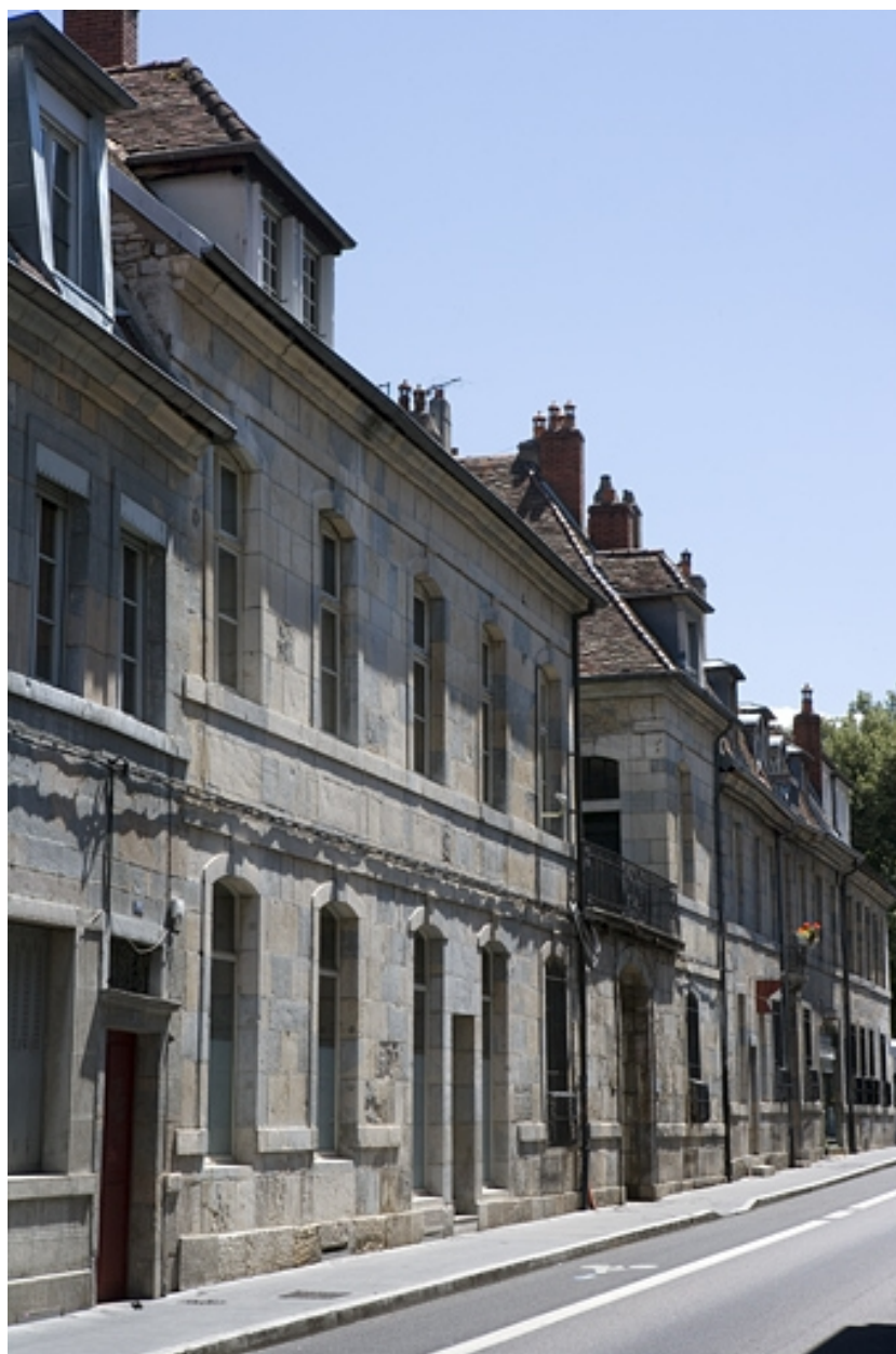
Vue d'ensemble de l'édifice, de trois quarts gauche.
