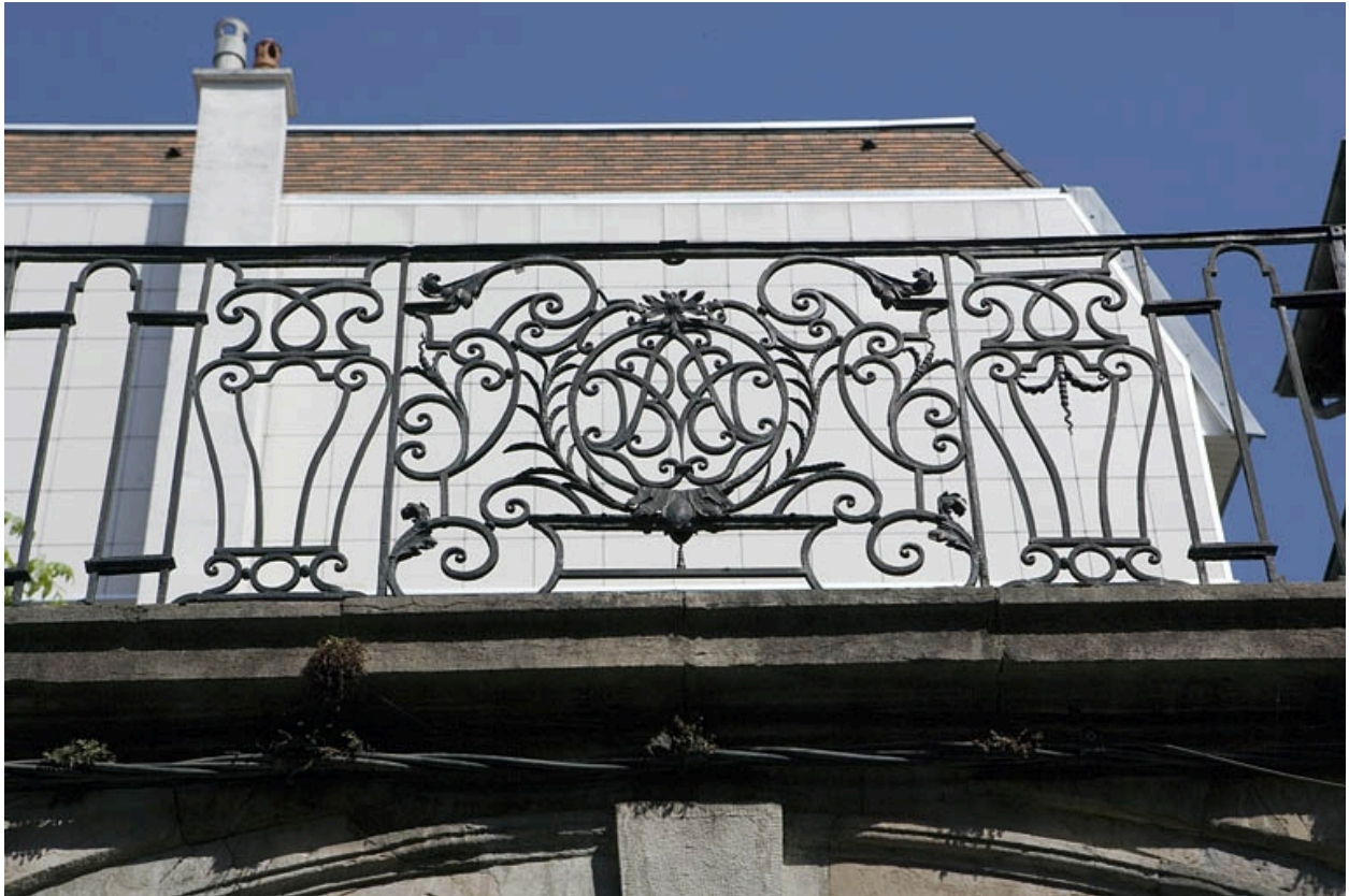
Passage au-dessus du portail dans clôture : détail de la partie centrale du garde-corps en ferronnerie.
