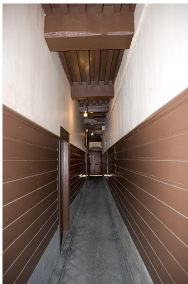
Détail du couloir à gauche du logis principal donnant accès à la première cour. Phot. Yves Sancey IVR43_20082500319NUC2A
