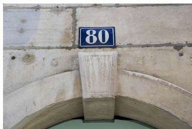
Détail de la date au-dessus de la porte d'entrée du couloir. Phot. Yves Sancey IVR43_20082500316NUC2A
