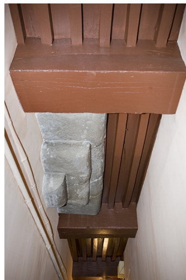
Détail de l'encorbellement en pierre de taille situé dans le premier couloir. Phot. Yves Sancey IVR43_20082500321NUC2A
