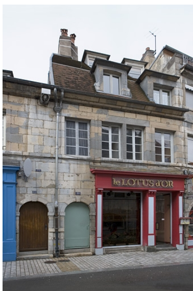
Vue rapprochée depuis la rue, de trois quarts gauche. Phot. Yves Sancey IVR43_20082500313NUC2A
