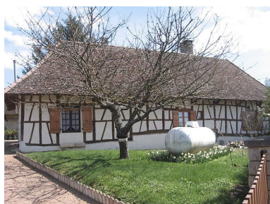
Vue d'ensemble de la façade de l'habitation.
