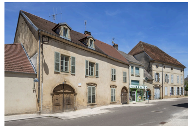
Le bâtiment de trois quarts gauche dans son contexte. Phot. Jérôme Mongreville IVR43_20217000390NUC4A
