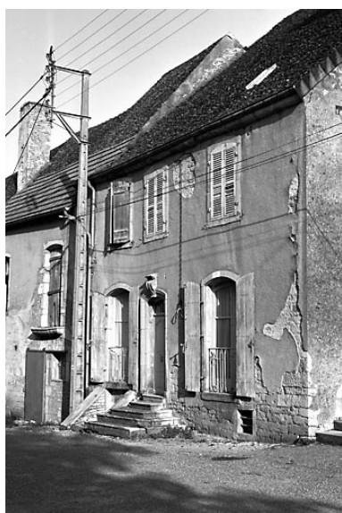
Façade antérieure. Phot. Dominique Dominguez IVR43_19807000558X
