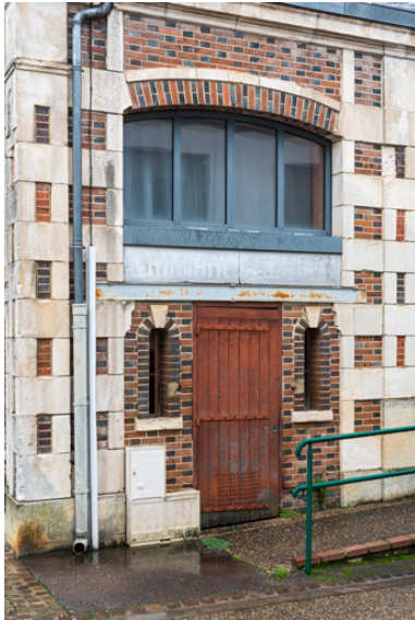
Ancienne chambre de sûreté. Phot. Pierre-Marie Barbe-Richaud IVR26_20238900045NUC4A
