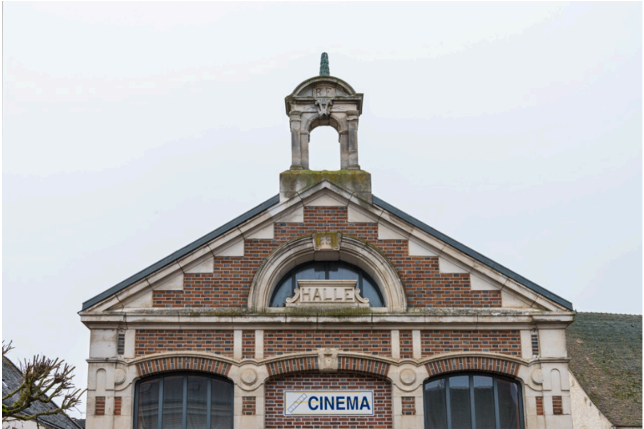
Façade antérieure : décor du pignon.
