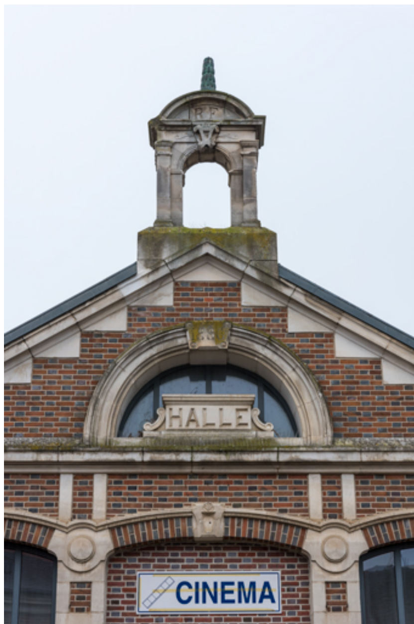
Façade antérieure : décor du pignon (cadrage vertical).
