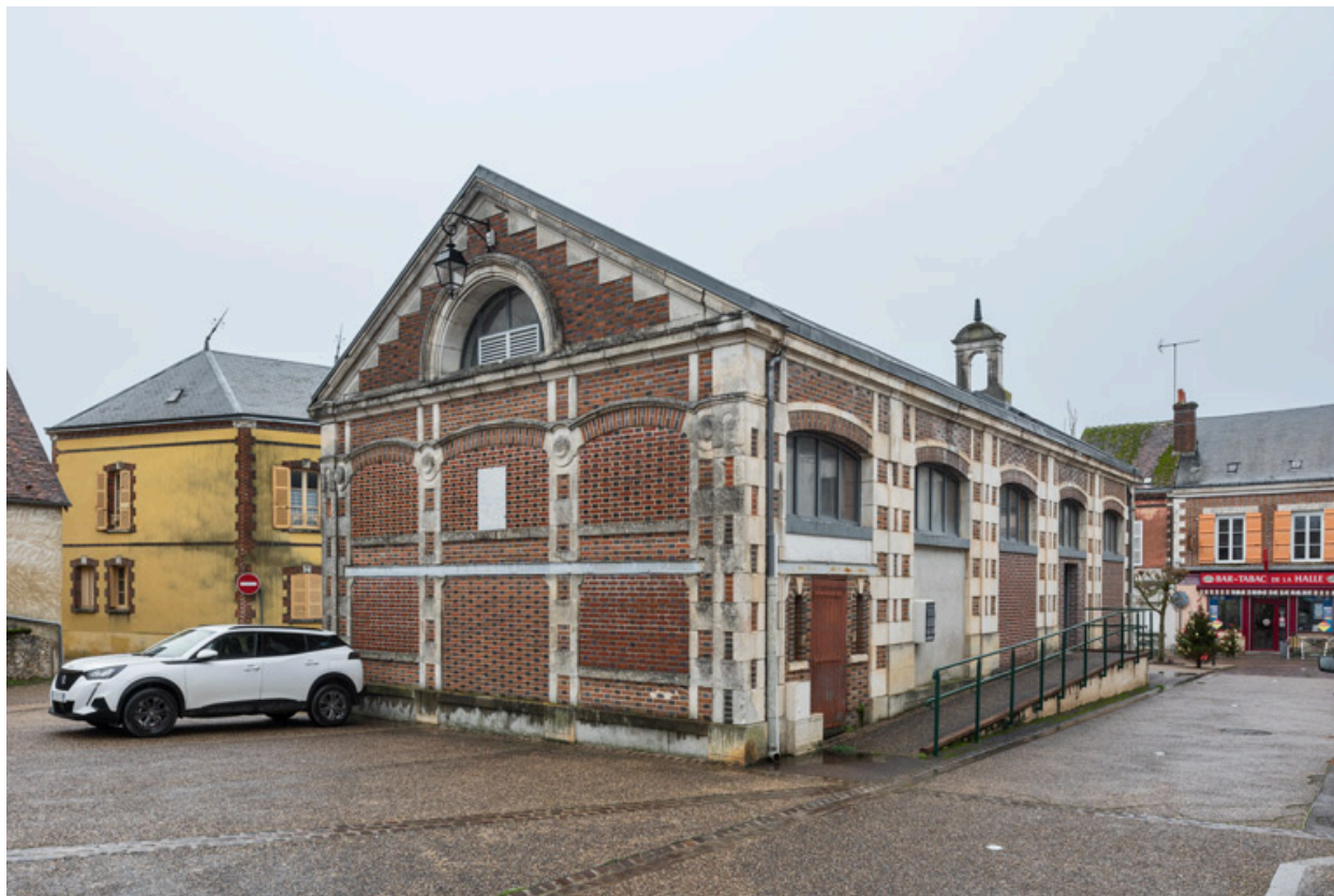
Façades postérieure et latérale gauche, de trois quarts droite.
