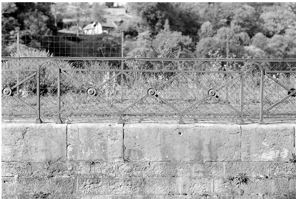
Garde-corps métallique, vu de face.
