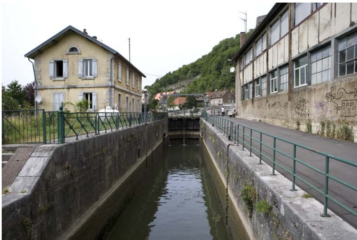
Intérieur du sas, depuis l'aval.
