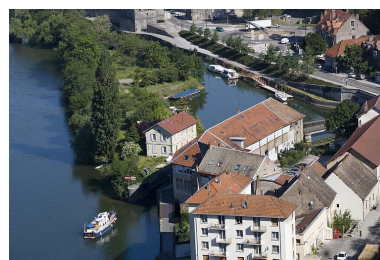
Vue d'ensemble plongeante, depuis l'aval. Phot. Yves Sancey IVR43_20062500204NUCA
