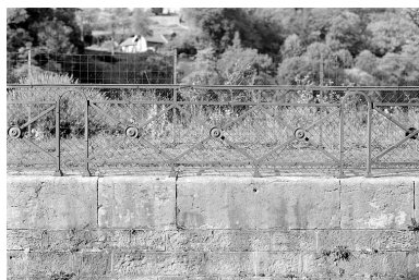
Garde-corps métallique, vu de face.
