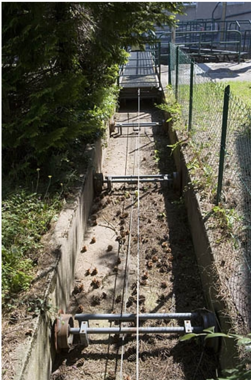
Système d'entraînement de la passerelle.
