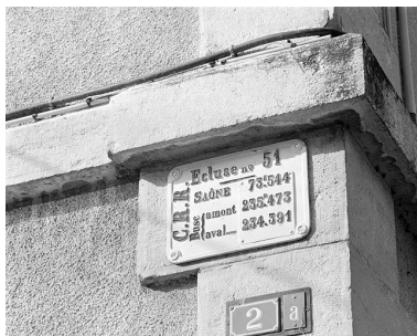
Plaque d'identification de l'écluse.
