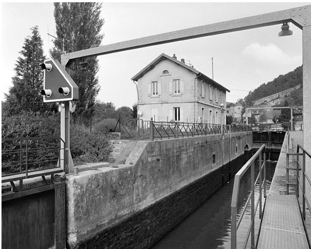
Intérieur du sas, de trois quarts.
